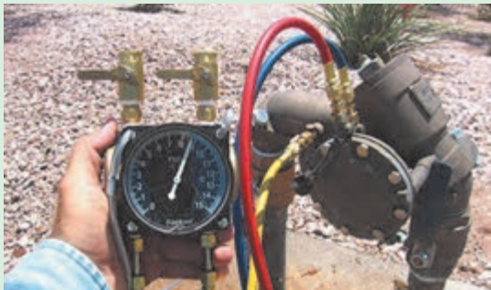
شکل ۳۱-۵. تنظیم فشار شیر فشار شکن
