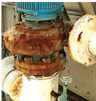
شکل ۵-۵- خوردگی الکتروشیمیایی قطعات فلزی
