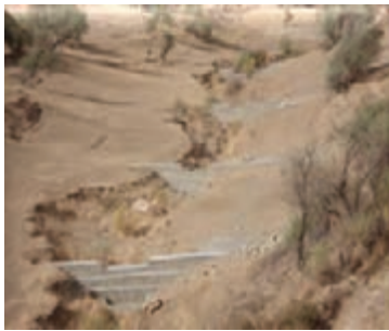
شکل ۱-۶۳- بند گابیونی (سنگ‌ها در تور سیمی)
