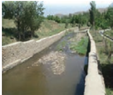
شکل ۱-۶۴- دیوار حاشیه رودخانه
