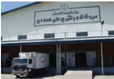
شکل ۲-۶- سردخانه بوعلی - همدان
