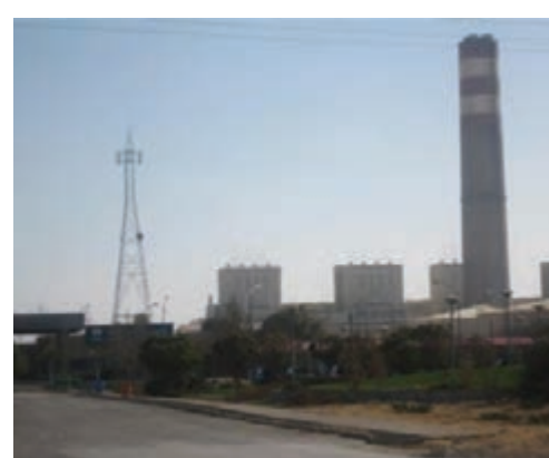
شکل ۱۹-۵- نیروگاه برق شهید مفتاح - فامنین
