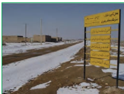
شکل ۶-۶- پروژه احداث راه روستایی - آق تپه
