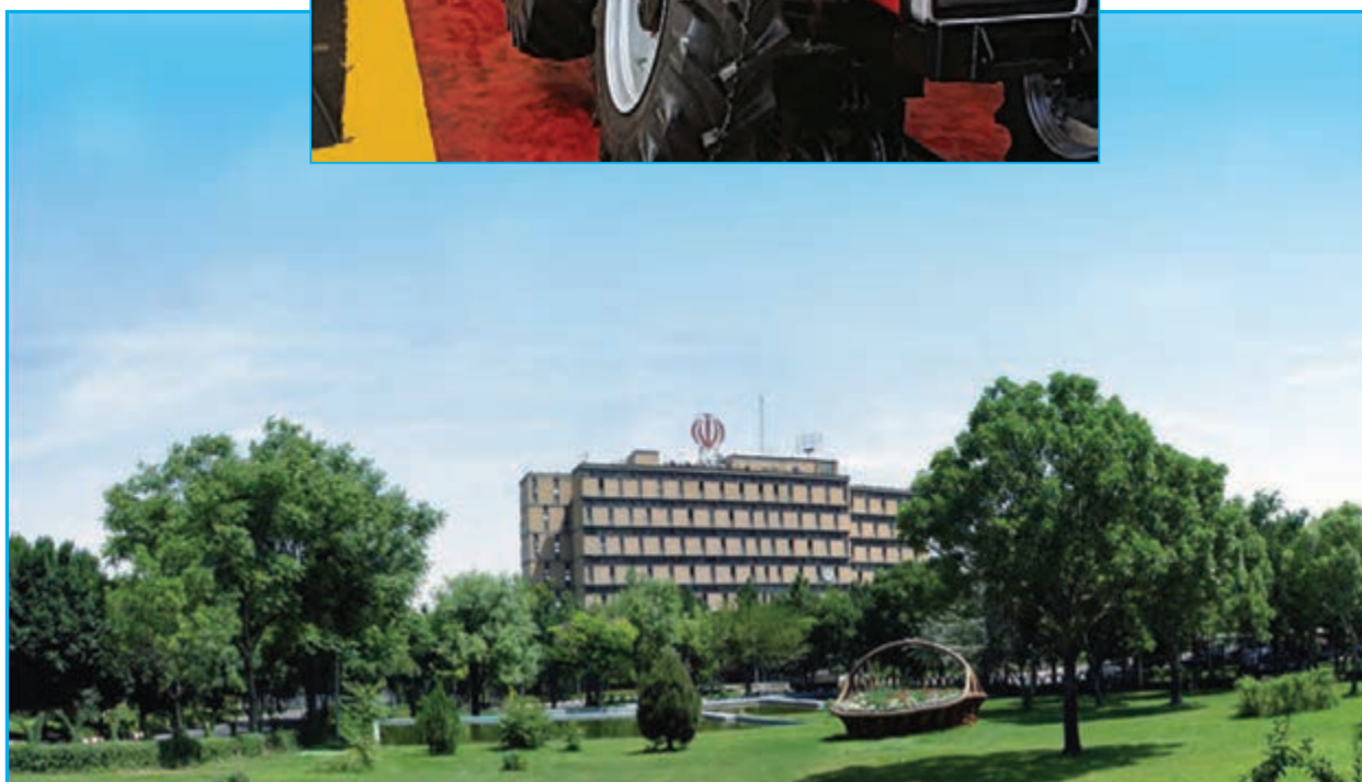
شکل ۲۹-۵- کارخانه تراکتورسازی تبریز
