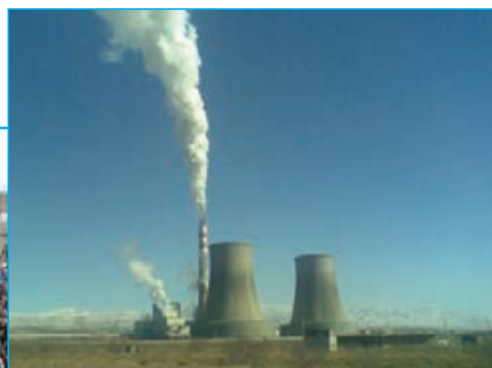
بناب- نیروگاه برق
