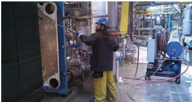
شکل ۱۵- روش فشار آب (جت آب)
