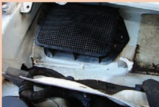
شکل ۲۰- اثر گرفتگی مجرا و عدم تخلیه آب
