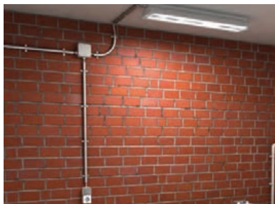
شکل ۳۲-۳- نمونه‌هایی از سیم‌کشی روکار
