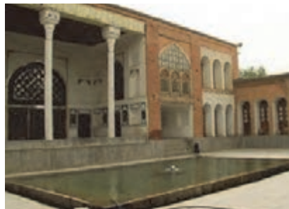
شکل ۴۴-۲- ایوان یک خانه سنتی در سنندج
