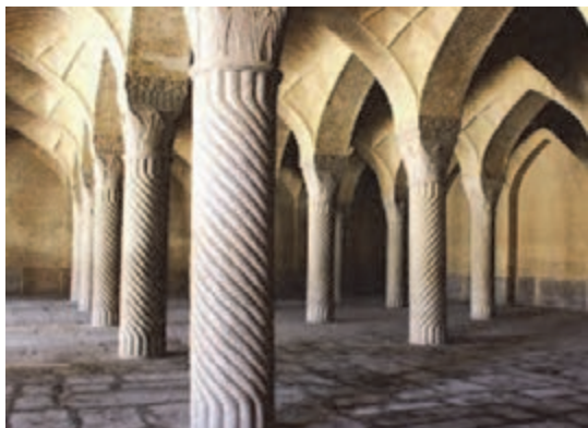
شکل ۲-۱۰۳- شیراز، ستون سنگی مسجد وکیل
