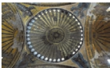
شکل ۹۴-۱- سقف گنبدی و نورگیرهای سقفی ایاصوفیه
