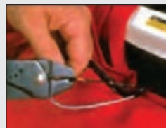
الف) لخت کردن سیم در محل قطعی
