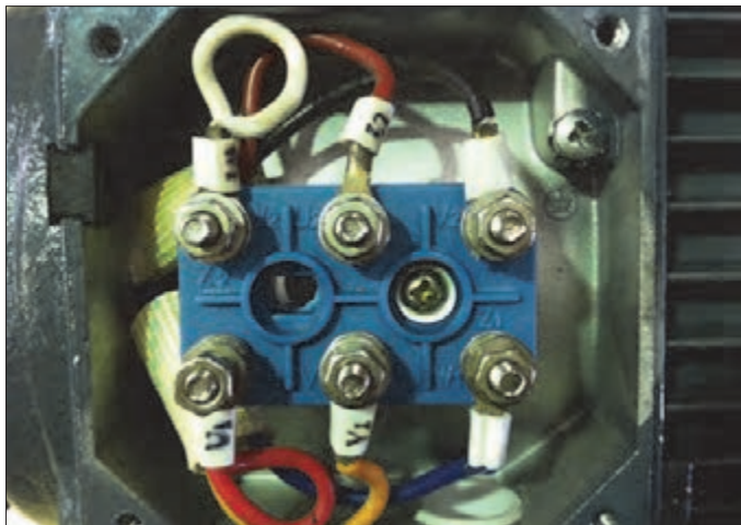
شکل ۴- تخته کلم موتور سه فاز
