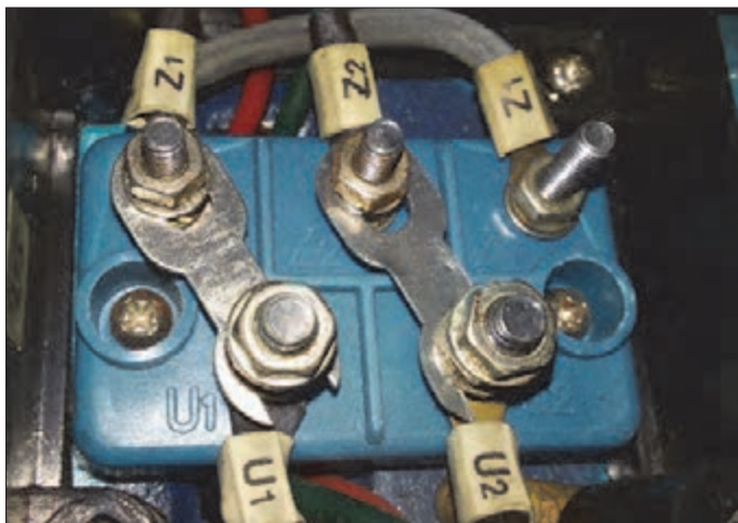
شکل ۵- تخته کلم موتور تک فاز
