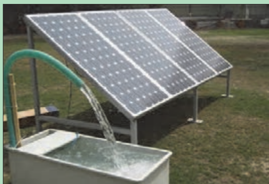
شکل ۳۸- کاربرد سامانه فتوولتاییک در پمپ چاه آب
