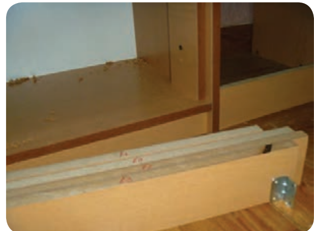
شکل ۱۶۶-۵- نصب پاسبک با استفاده از گونیای فلزی
