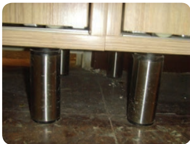
شکل ۵-۸ - پایه‌های قابل تنظیم
