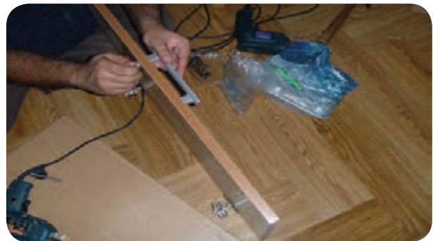
شکل ۱۵۹-۵- نصب دستگیره در کمد
