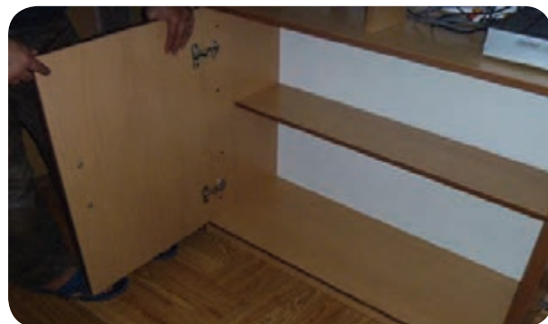
شکل ۵-۱۶۴- نصب در کمد زیر جای تلویزیون
