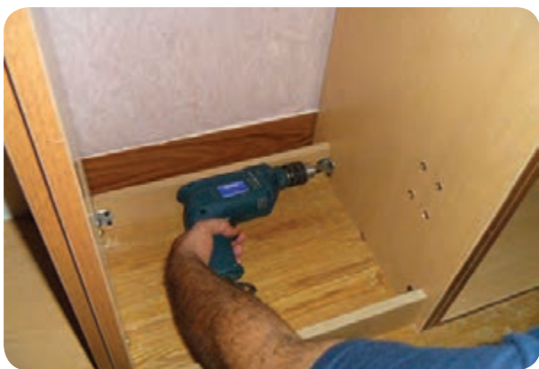
شکل ۱۸۰-۵- نصب پاسنگ‌ها
