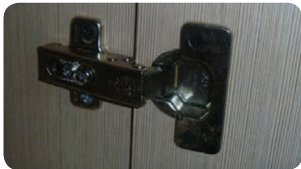
شکل ۵-۱۶۳- نصب لولای گازی فنردار به در کمد
