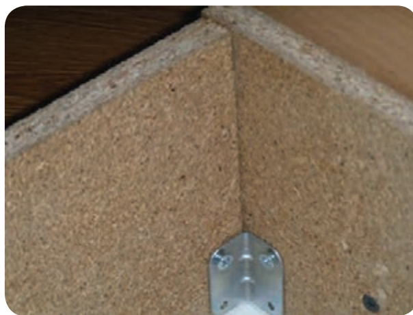
شکل ۱۵۵-۵- اتصال جلو و عقب جعبه به وسیله گونیای فلزی گوشه کار
