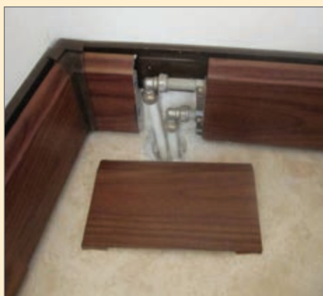
اتصال لوله‌کشی رادیاتور قرنیزی با کاور نهایی
