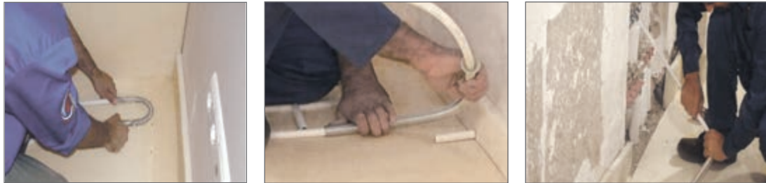
استفاده از فنر برای خم کردن لوله
