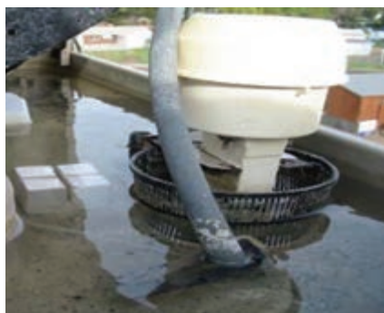
شیلنگ رابط پمپ و چهارراهی
