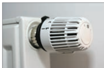
رادیاتور با شیر ترموستاتیکی
