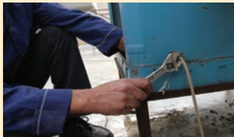
نصب لوله به شیر شناور
