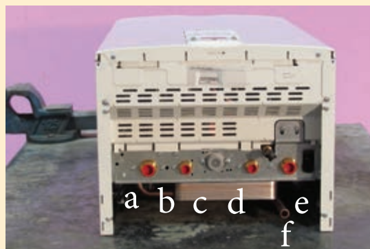
چگونگی اتصال لوله‌های پکیج به سیستم
