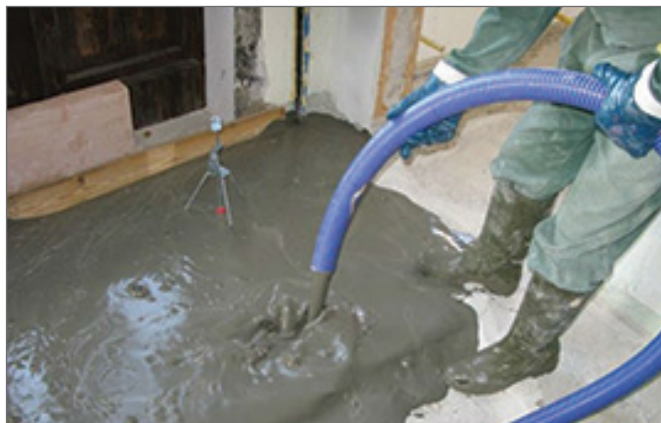
کف‌سازی ساختمان با فوم بتن
