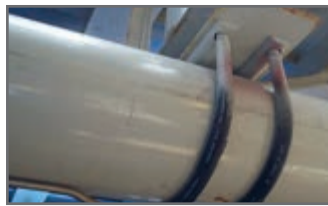
شکل ۱۷- تکیه‌گاه لوله افقی
