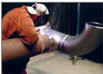
شکل ۶۵- انشعاب‌گیری با استفاده از اتصالات جوشی
