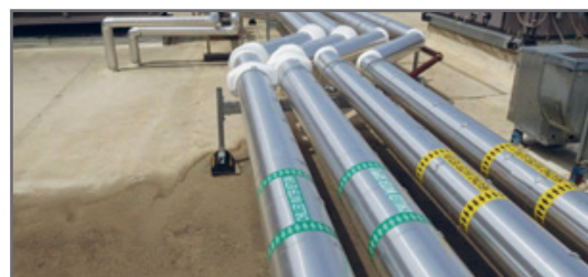
شکل ۳۴- عایق الاستومری با پوشش آلومینیوم
