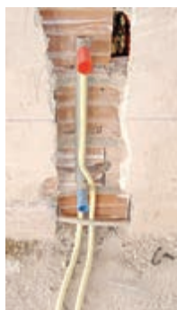
شکل ۶۲- اتصال سر لوله رادیاتور با شابلون زیرکار
