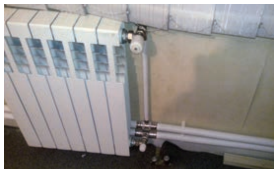
شکل ۶۱- اتصال سر لوله رادیاتور روکار
