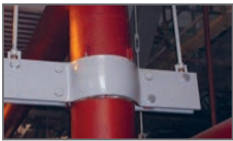
شکل ۱۸- تکیه‌گاه لوله قائم
