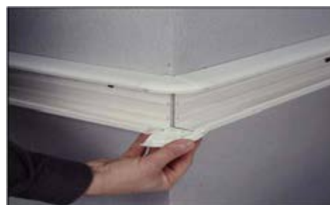
شکل ۴۴- نصب درپوش ترانکینگ زاویه دار
