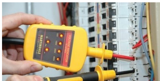
شکل ۵۴- تست تابلو با نشانگر ولتاژ
