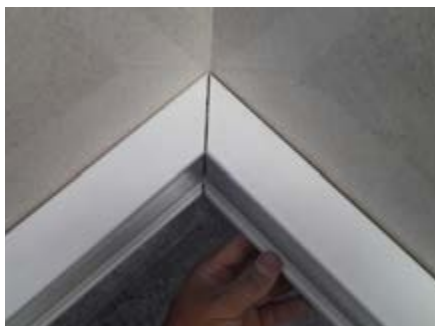
شکل ۵۰- برش و فارسی بر کردن ترانکینگ
