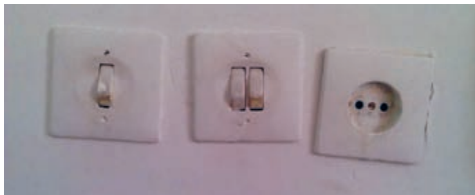
شکل ۱- نصب غلط کلید و پریز
