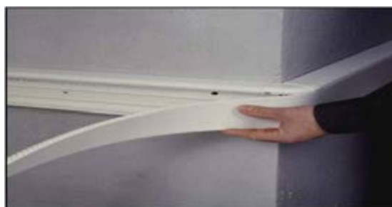
شکل ۴۴- نصب درپوش ترانکینگ زاویه دار
