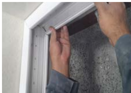
شکل ۵۰- برش و فارسی بر کردن ترانکینگ
