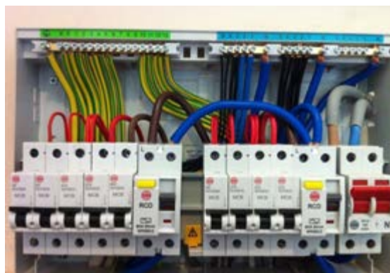
شکل ۹۲- سیم‌کشی نول و اتصال زمین
