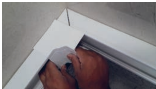
شکل ۵۱- نصب زانوی داخلی
