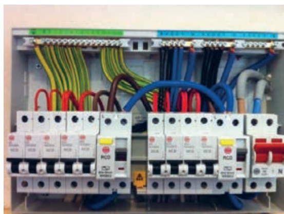
شکل ۴۹- اتمام سیم کشی قطعات تابلو
