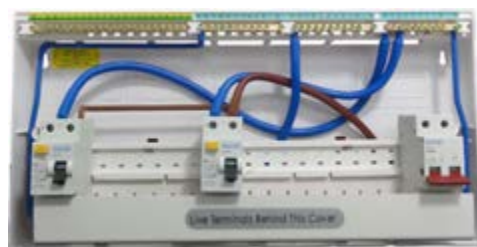
شکل ۹۰- نصب دو RCD
