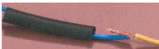
شکل ۲۲- عایق‌کاری اتصال
