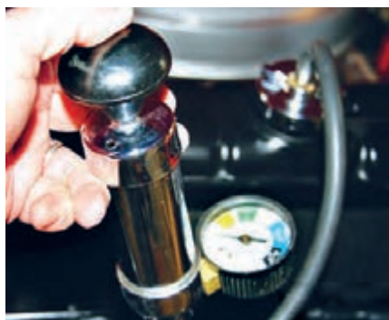
شکل ۶. آزمایش نشت یابی تحت فشار
