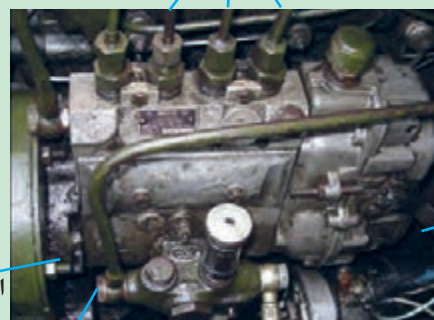
لوله های انژکتورها
