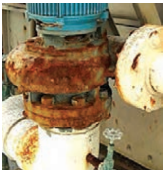
شکل ۵-۵۰- خوردگی الکتروشیمیایی قطعات فلزی
