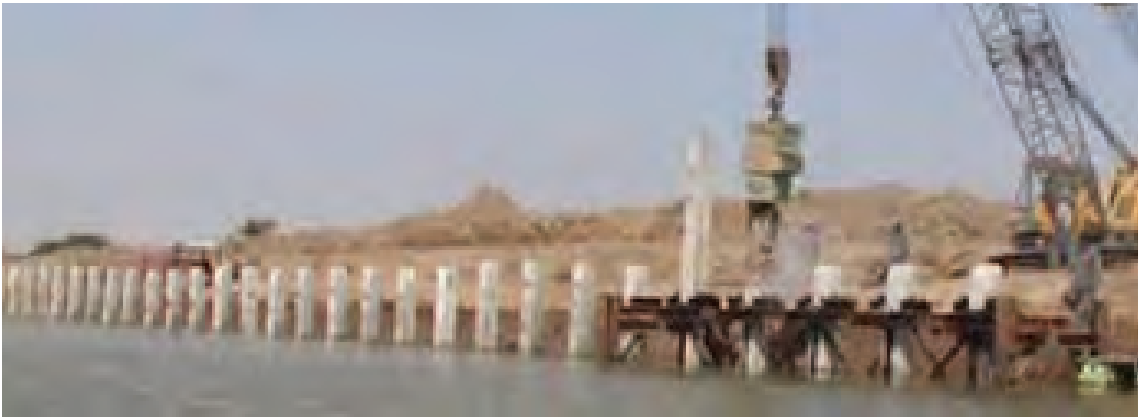
شمع کوبی کنار سواحل از برخورد شدید آب با خاک کنار ساحل جلوگیری می‌کند
