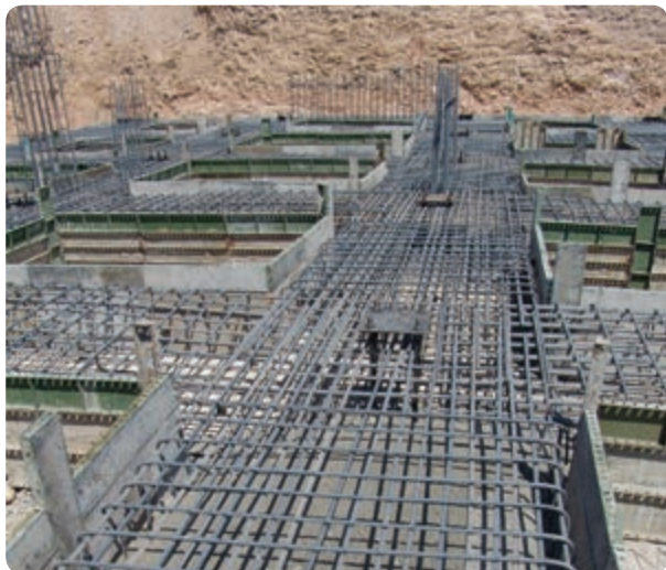
شکل ۳-۵- یکی از روش‌های کاهش خطر زلزله
