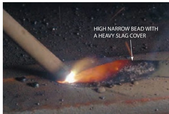
شکل ۴-۳۷: جوشکاری با طول قوس بسیار کم
