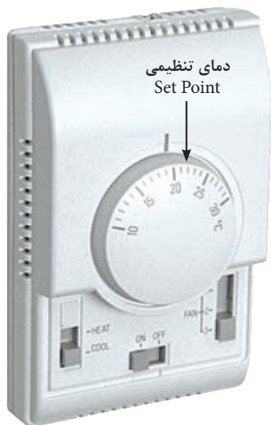
شکل ۴۷ - ترموستات فن کوئل
