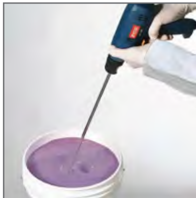
۱ مخلوط کردن لعاب با استفاده از همزن
