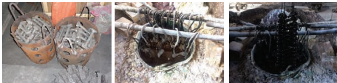
شکل ۲۶- تمپر کردن قطعات
