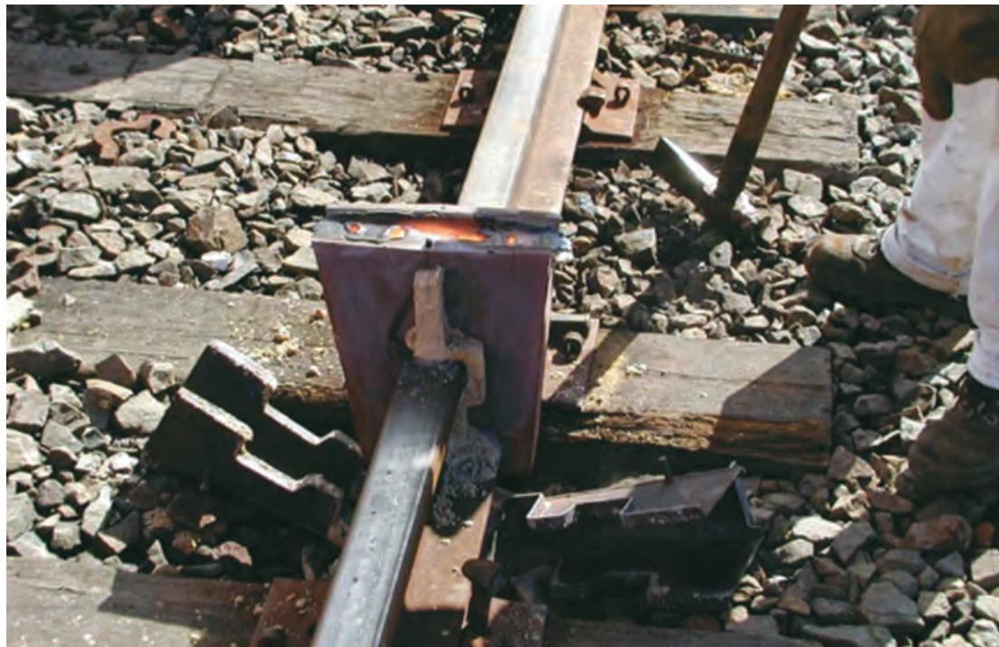
شکل ۲۵- باز کردن گیره و حفاظ قالب
