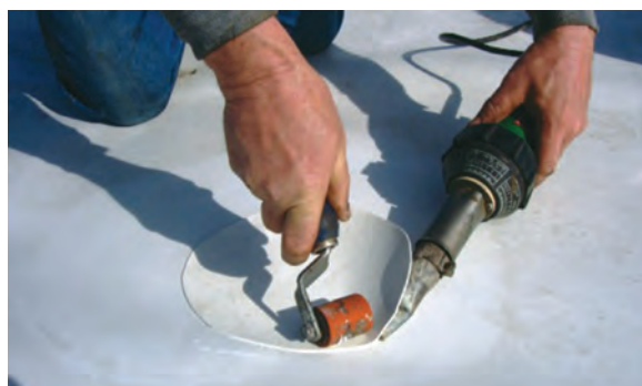
شکل ۱۲- جوشکاری با گاز داغ به صورت دستی
