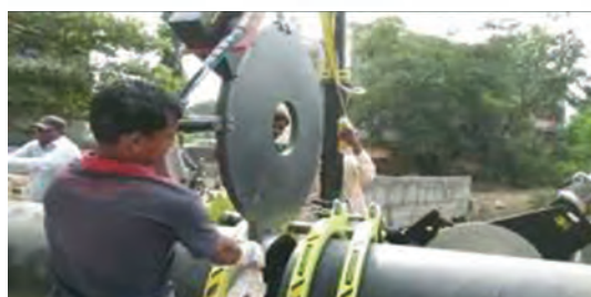
شکل ۱۹- جوشکاری لب به لب Butt Fusion
