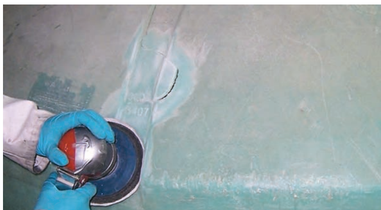
شکل ۲۷- آماده‌سازی سطوح پلاستیکی قبل از جوشکاری
