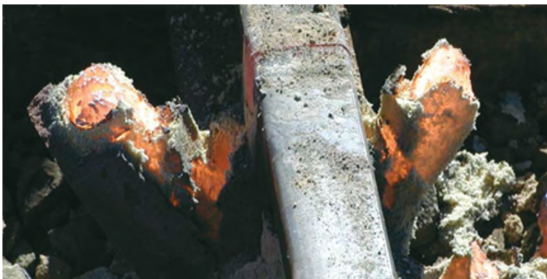
شکل ۲۷- برش گرده اضافی جوش
