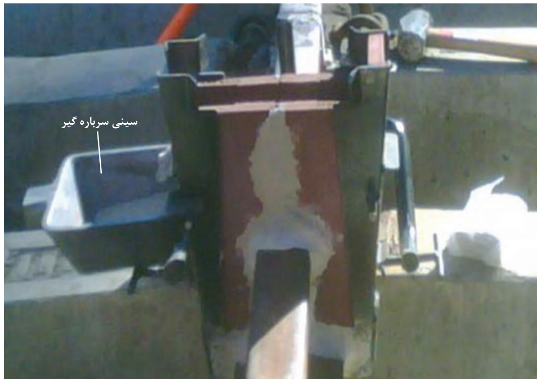
شکل ۲۰- نصب سینی‌های سرباره گیر
