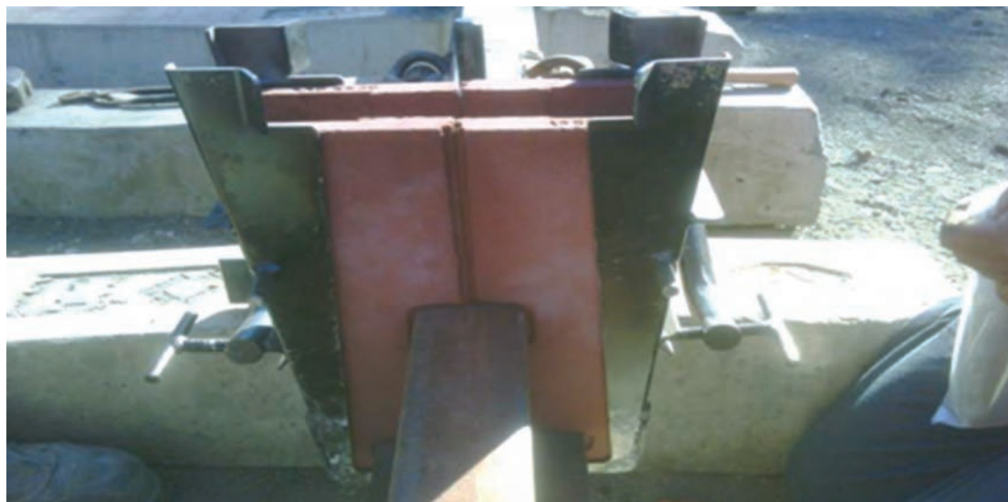
شکل ۱۸- نصب قالب اطراف ناحیه اتصال
