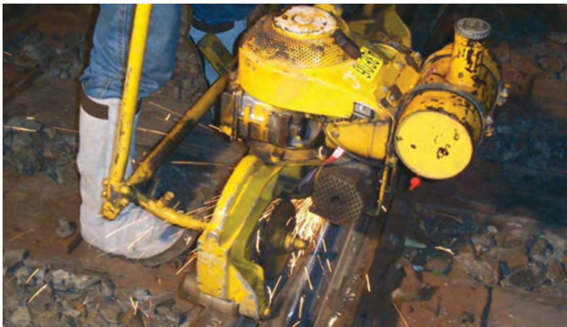
شکل ۲۸- سنگ زنی و پرداخت کاری سطح گرده
