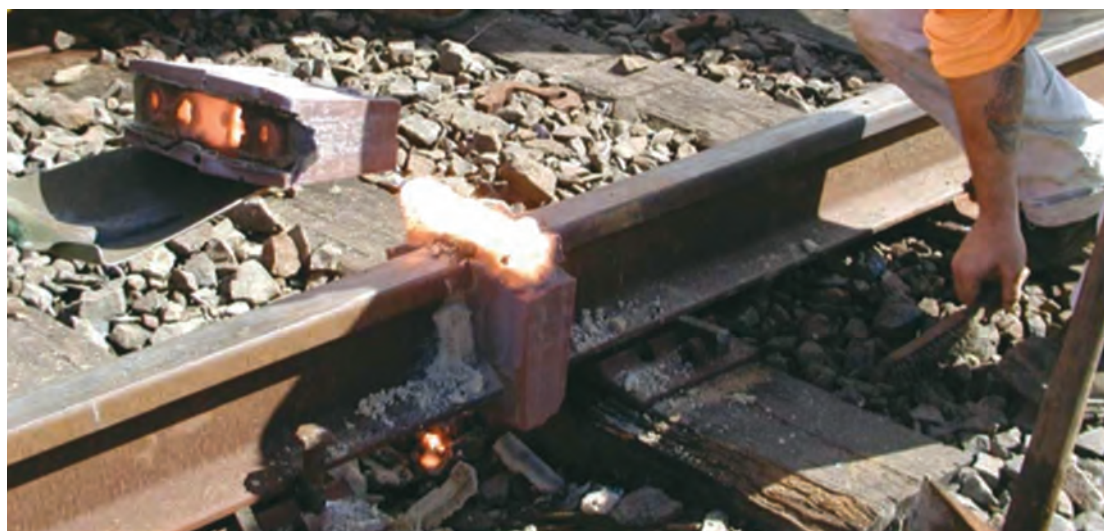
شکل ۲۶- شکستن قسمت فوقانی قالب
