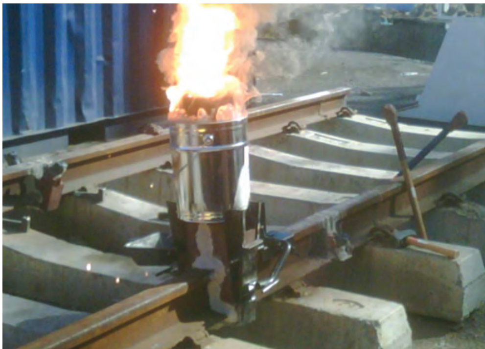
شکل ۲۳- نمایی از انجام واکنش ترمیت
