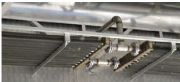
شکل ۴۱- انتقال حرارت کویل‌ها با هوای اطراف خود
