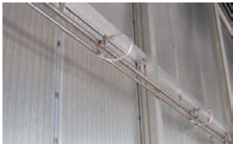
شکل ۳۵- محل قرارگیری اسپری بخار در کوره
