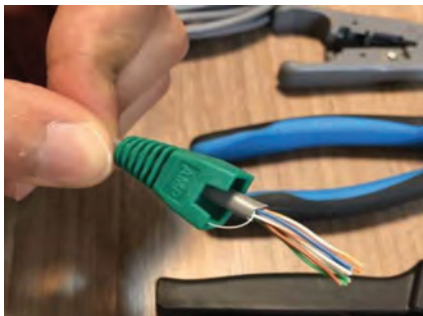
شکل ۲۶- وارد کردن کاور سوکت سر کابل
