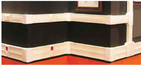
شکل ۵۳ - محل تقاطع ترانک‌ها و داکت‌ها
