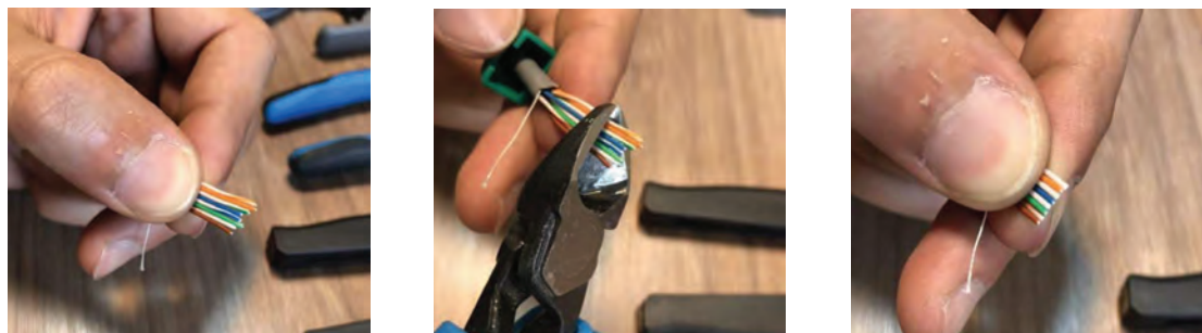
شکل ۲۷- مرتب کردن سیم‌های رنگی مطابق استاندارد
