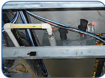
شکل ۸- نمونه اتصال لوله تخلیه به تشتک
