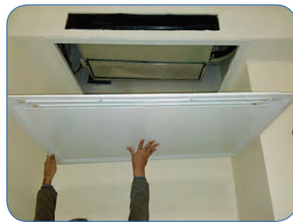
شکل ۱۴. نمونه دریچه دسترسی و برگشت هوا
