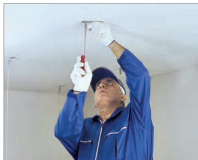
شکل ۳-۱۱۶- اتصال قطعه HT ۹۰ به سقف اصلی شکل ۳-۱۱۷
