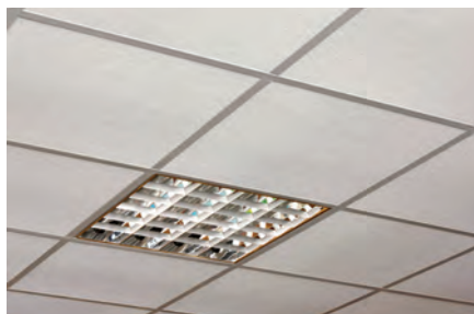
شکل ۳-۴- سقف کاذب مشبک
