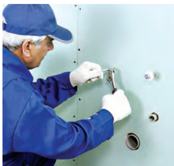
شکل ۱-۱۵۸- اتصال مهار روشویی به تراورس
