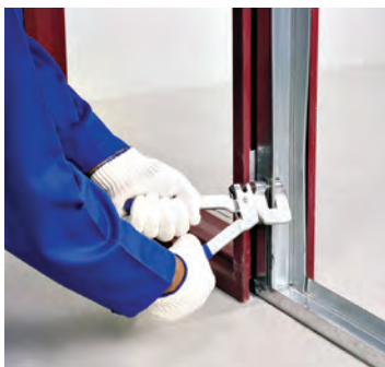
شکل ۱۲۱-۱- اتصال پایین استاد با پانچ
