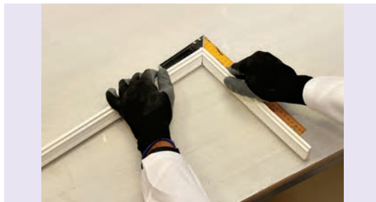
شکل ۲۲۹-۱- کنترل گونیا بودن قطعات قبل از نصب
