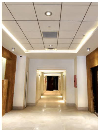
شکل ۹۳-۳- نمونه تمام شده سقف کاذب مشبک
