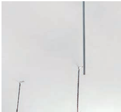
شکل ۴۸-۳ تکمیل شدن آویزها
