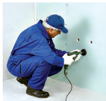
شکل ۱-۱۵۷- ایجاد خروجی‌های تأسیساتی به وسیله گردبر
