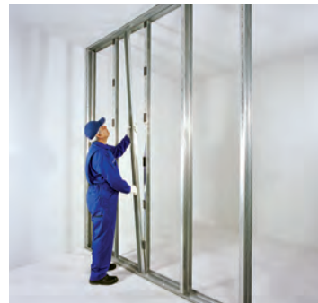
شکل ۸۴-۱- اجرای ردیف دوم استاداها
