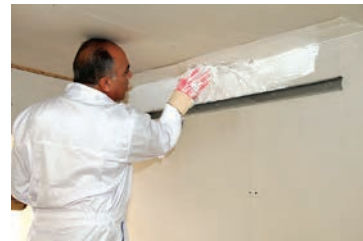
شکل ۲۳۷-۱- اجرای اندود گچ
