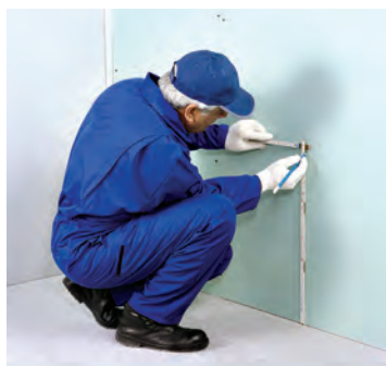
شکل ۱-۱۵۶- تعیین محل خروجی‌های تأسیساتی
