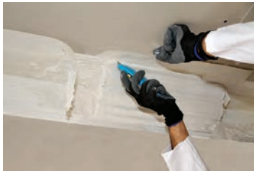
شکل ۲۳۹-۱- تمیز کردن اطراف کار
