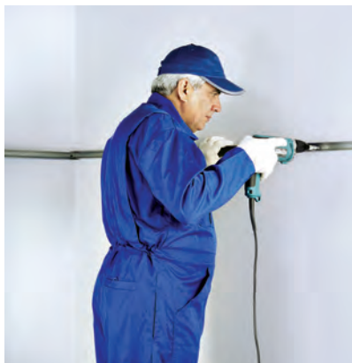
شکل ۳-۴۵- نصب سازه تراز
