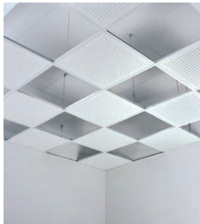
شکل ۱۲۳-۳- تایل گذاری شطرنجی جهت ایجاد نشست اولیه شکل ۱۲۴-۳- نحوه عبور تایل از میان سازه‌ها
