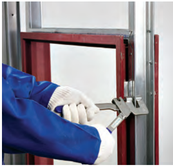
شکل ۱۳۰-۱- اتصال رانر نعل درگاه به استاده‌ها با پانچ
