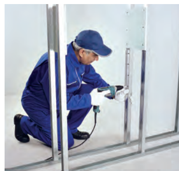
شکل ۱-۱۵۴- اتصال قطعات نشی L25 به استادهای مجاور
