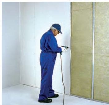
شکل ۸۸-۱- اجرای پانل‌ها در هر طرف دیوار
