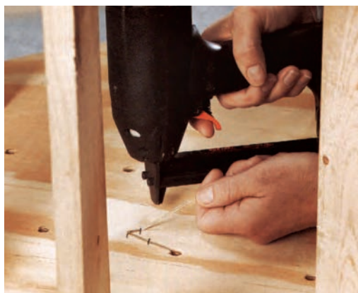
شکل ۴-۶۰- ثابت کردن نخ لمسه از پشت تخته
