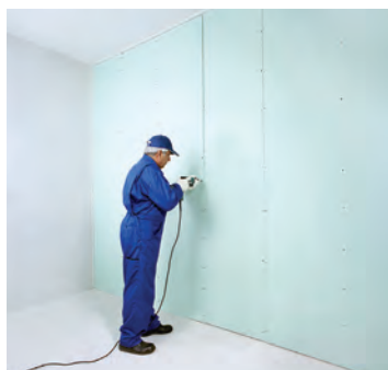
شکل ۱۰۱-۱- اجرای لایه دوم پانل‌ها
