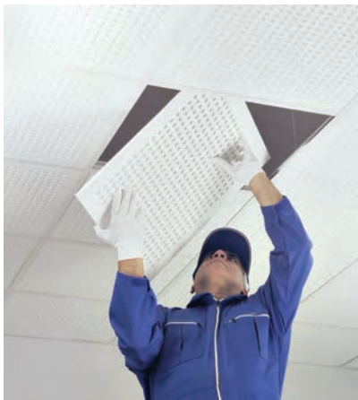
شکل ۱۲۳-۳- تایل گذاری شطرنجی جهت ایجاد نشست اولیه شکل ۱۲۴-۳- نحوه عبور تایل از میان سازه‌ها
