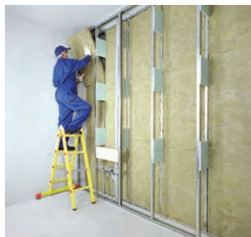
شکل ۹۹-۱- اجرای عایق معدنی
