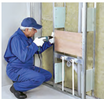
شکل ۱-۱۵۵- اتصال تراورس (تخته چند لای) به قطعات نشی L25
