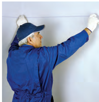
شکل ۳-۴۴- مشخص کردن محل نصب سازه تراز با ریسمان رنگی
