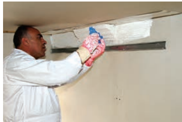
شکل ۲۳۸-۱- کشیدن ابزار
