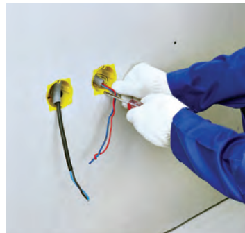
شکل ۱۷۶- گیره‌ها توسط پیچ گوشتی جمع می‌شوند.
