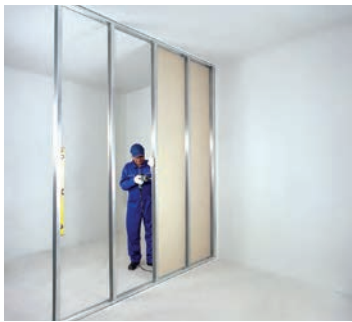
شکل ۱-۶۲- اجرای پانل‌ها در یک طرف دیوار
