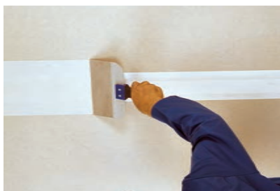
شکل ۸۲-۳- قرار دادن نوار درزگیر بر روی بتونه
