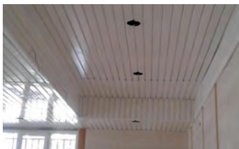
شکل ۳-۳- سقف کاذب فلزی
