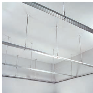
شکل ۳-۵۹- سازه‌های باربر تکمیل شده
