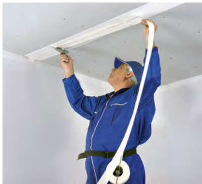
شکل ۸۱-۳- اجرای لایه بتونه در محل درز (کاردک در جهت عمود بر درز کشیده می شود تا بتونه کاملاً در درز نفوذ کند).
