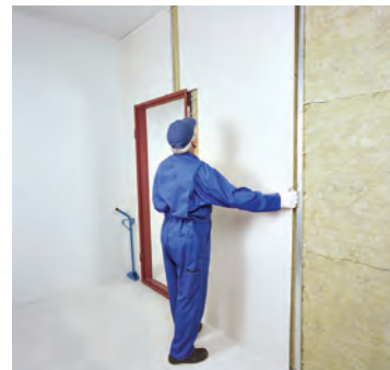
شکل ۱۴۳-۱- اجرای پانل چهارم دور چهارچوب
