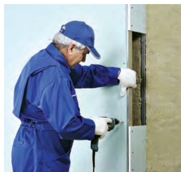
شکل ۱۰۰-۱- اجرای پانل‌ها در طرف دیگر دیوار
