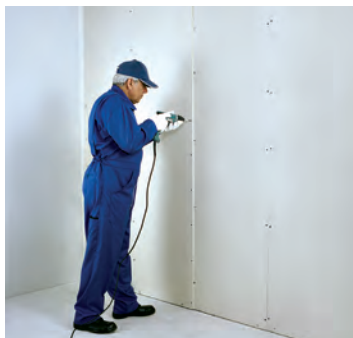
شکل ۸۹-۱- اجرای لایه دوم پانل‌ها
