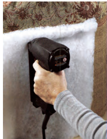
شکل ۴-۶۶- کوبیدن اسفنج بدنه
