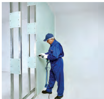
شکل ۹۸-۱- اجرای پانل‌ها در یک طرف دیوار
