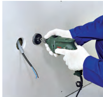
شکل ۱۷۳- خروجی‌های تأسیساتی به وسیله گردبر ایجاد می‌شوند.
