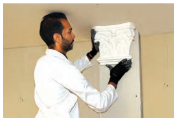
شکل ۲۴۲-۱- اتصال قطعه اول به ستون
