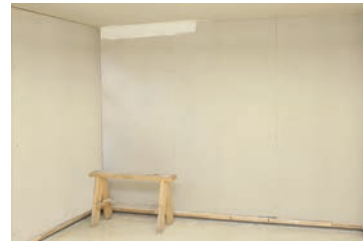
شکل ۲۳۴-۱- اجرای بتونه (زیر سازی)
