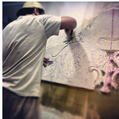
شکل ۳۵-۲- مراحل اجرای گچ‌بری به شیوه درجا
