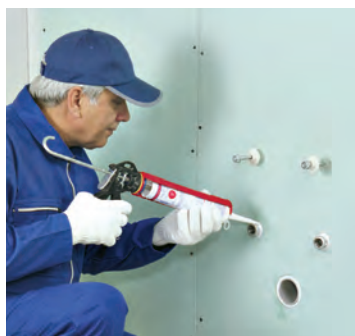
شکل ۱-۱۵۹- اجرای خمیر درزبند در اطراف خروجی‌های تأسیساتی
