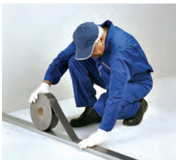
شکل ۴۴-۱- اجرای نوار عایق (با دوردیف سیلیکون) بر پشت جان رانر کف و سقف
