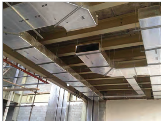
شکل ۱۹-۲- سقف با کانال تأسیساتی
