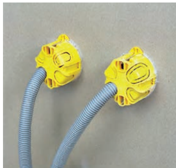
شکل ۱۷۷- گیره‌ها با پانل درگیر شده و قوطی برق در جای خود محکم می‌شود.
