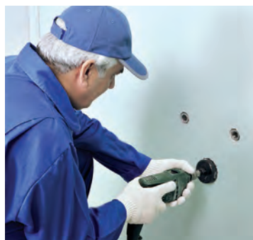
شکل ۱۰۲-۱- ایجاد خروجی تأسیسات به وسیله گرد بر
