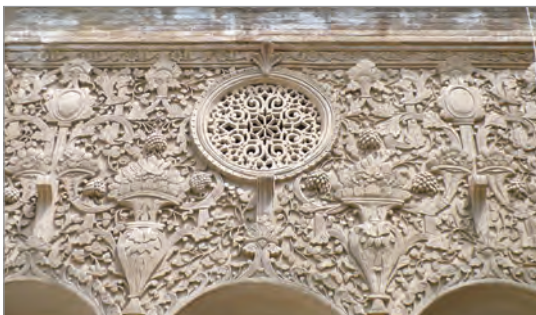
شکل ۲-۲- گچ بری نمای بیرونی
