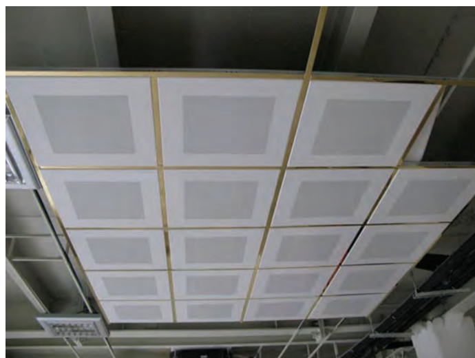
◀ شکل ۱-۶۰- سقف کاذب تایل آلومینیوم با شبکه فلزی
