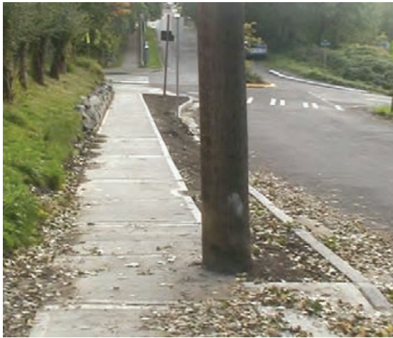
▲ شکل ۳-۴۰ به کارگیری قطعات مجزا در کف‌سازی
