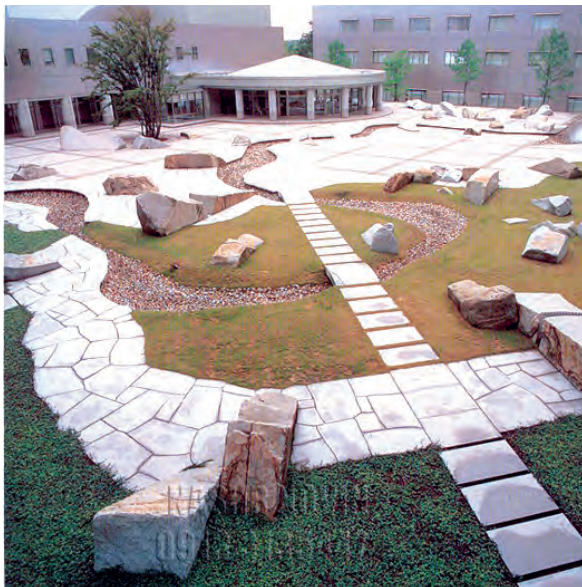
▲ شکل ۱-۸ کف‌سازی در محوطه خارجی ساختمان
