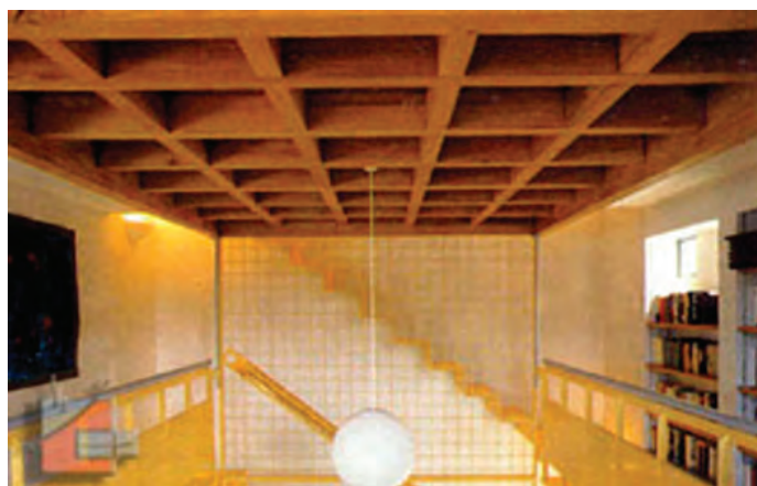
◀ شکل ۱-۵۹- سقف کاذب مشبک چوبی
