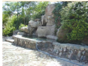
▲ شکل ۳-۴۷ اجرای پیاده‌رو با رویه‌ی سنگی
