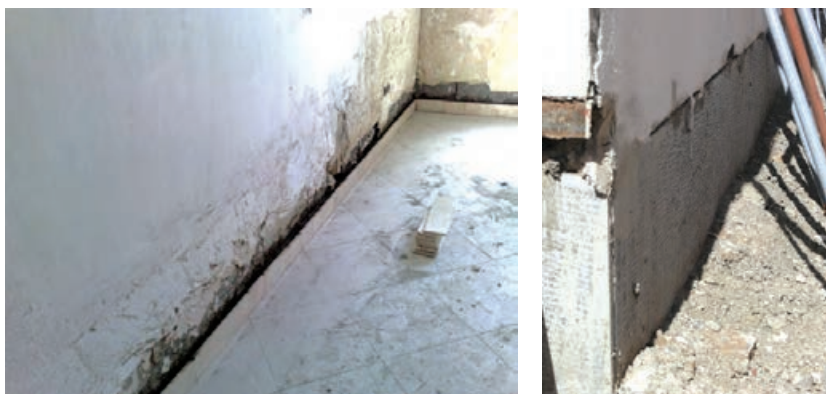
شکل ۱-۲۴ سنگ ازاره پای دیوار خارجی ▲ شکل ۱-۲۵ سنگ قرنیز پای دیوار داخلی ▲
