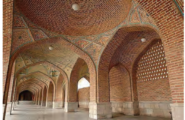
▲ شکل ۴-۶۸ قوس های آجری (مسجد کبود تبریز)
