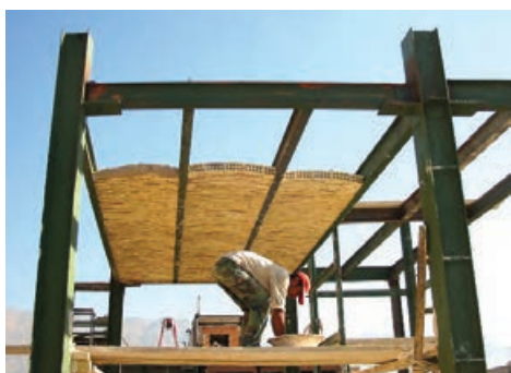
شکل ۴۱-۱ سقف طاق ضربی
