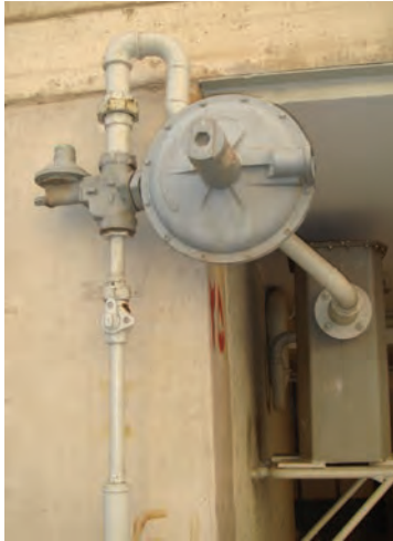
▲ شکل ۲-۹۳ علمک و رگولاتور روی آن
