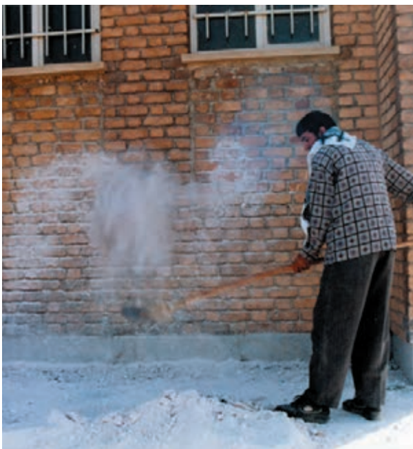
گردپاشی خارج از جایگاه
