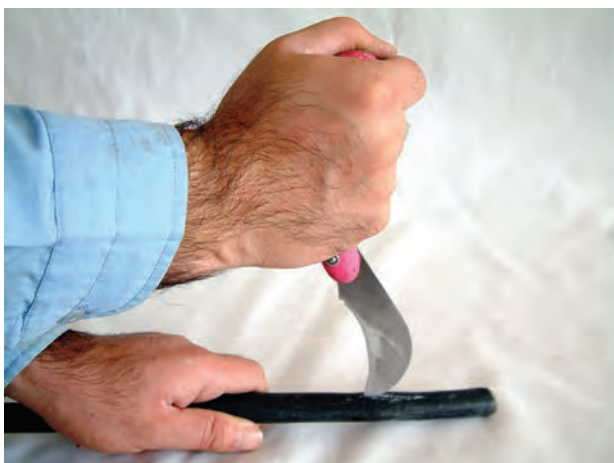
شکل ۳۲-۵- روکش برداری غلط
