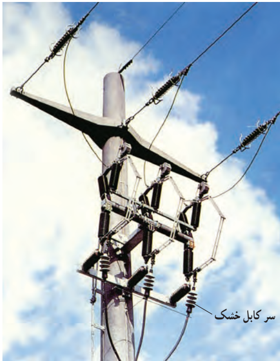
شکل ۶-۶- سر کابل خشک حرارتی هوایی
