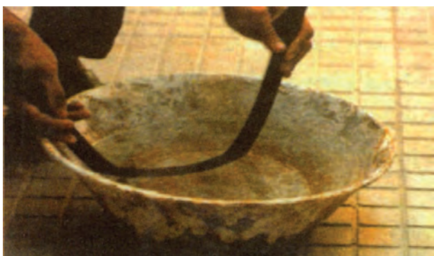
شکل ۴-۴۵- سرد کردن لوله پس از خم‌کاری
