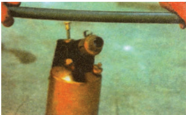
شکل ۴-۴۳- حرارت دادن لوله‌ی PVC
