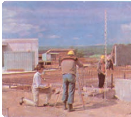
شکل ۱۴-۸- طریقه‌ی نگاه داشتن میر
