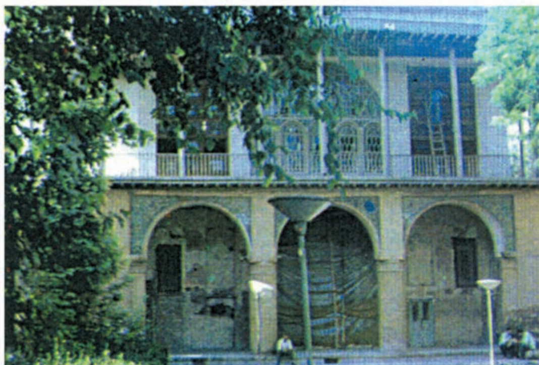
شکل ۱۲۱- عمارت چهلستون قزوین
