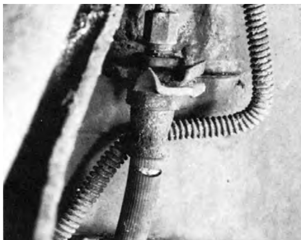
شکل ۱-۶۹- کنترل لوله‌ها و اتصالات
