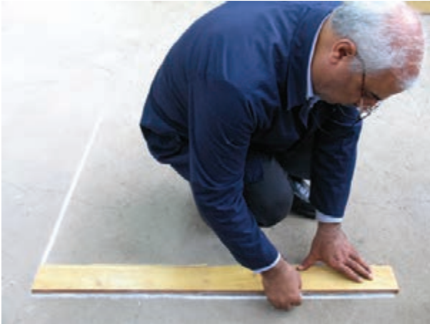
شکل ۳-۱- علامت گذاری فونداسیون
