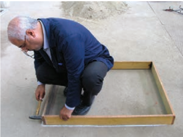
شکل ۴-۱- قالب بندی فونداسیون
