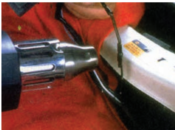
شکل ۱-۱۵۰- عایق کاری محل اتصال سیم ها
