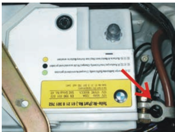
شکل ۲-۱۰۹- باز کردن اتصال منفی باتری
