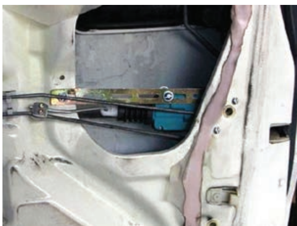
شکل ۳۷-۲- نحوه‌ی اتصال عملگر الکتریکی
