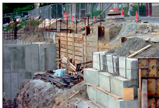
شکل ۹۱-۱ مهاربندی با دیوار مانع چوبی
