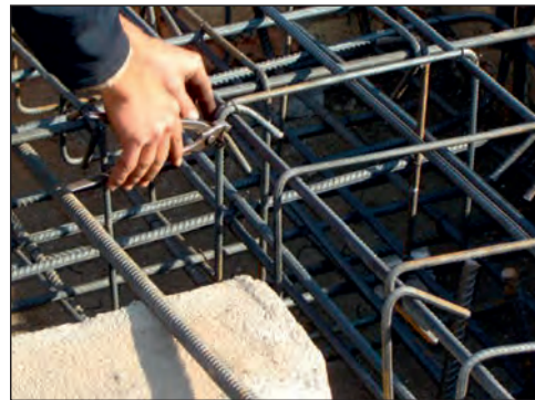
شکل ۲-۱۴۱ بستن خاموت دورآرماتور اصلی شناژ
