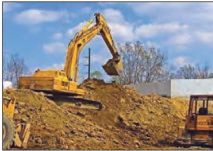
شکل ۱-۱۳- کندن زمین با وسایل مکانیکی
