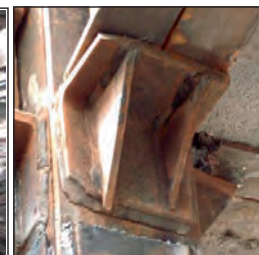
اتصال تیر به ستون به صورت لچکی
