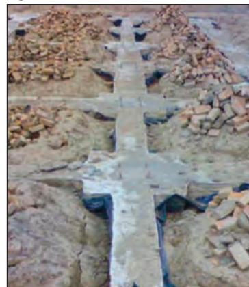
شکل ۷۳-۲ پی و شناژ بعد از بتن ریزی
