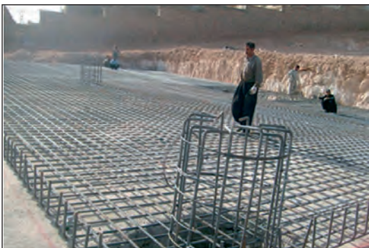
شکل ۱۵۲-۲ آرماتورگذاری پی صفحه‌ای با ستون‌های بتنی
