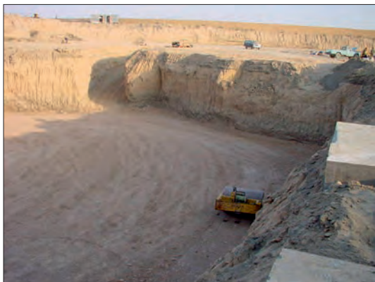
شکل ۸۴-۱ زمین گودبرداری شده
