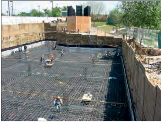
شکل ۱-۶۲ پی بتن مسلح یکپارچه (رادیه ژنرال)
