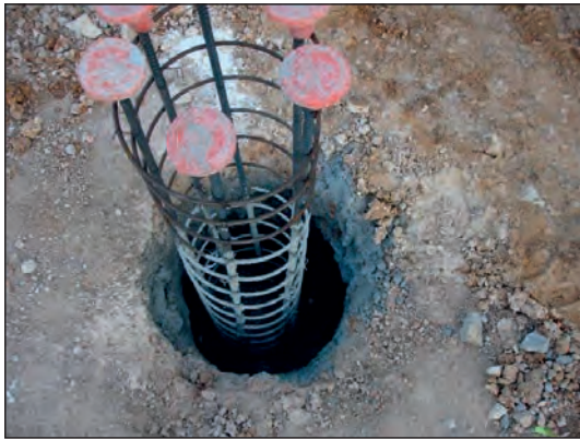
شکل ۱-۷۳ پی چاهی در حال اجرا
