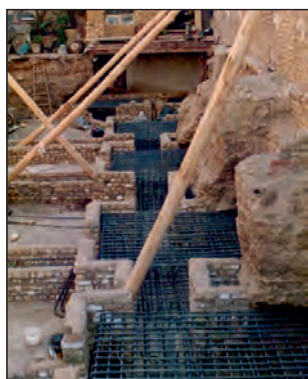
شکل ۹۰-۱ مهاربندی با شمع چوبی
