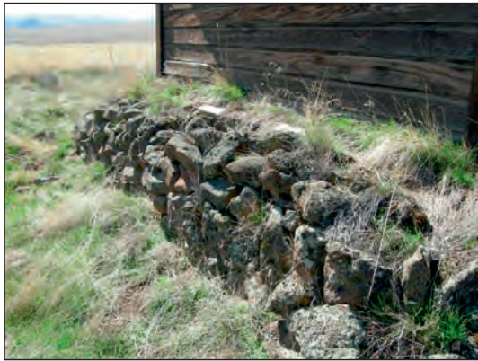
شکل ۱-۳۲ پی سنگی با سنگ لاشه
