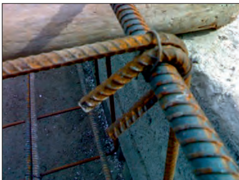
شکل ۲-۱۴۲ قلاب سرخاموت و بستن آن با مفتول
