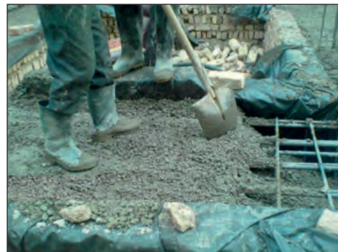
شکل ۲-۱۴۵ مرحله ی بتن ریزی داخل پی
