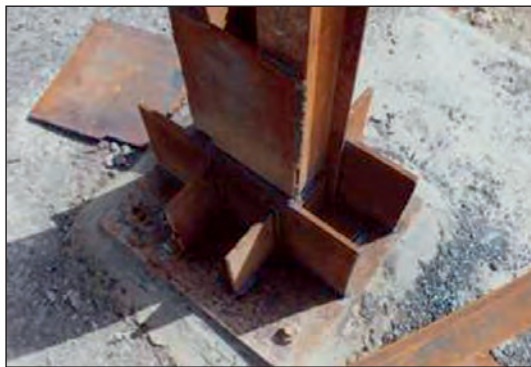
شکل ۱۶۸-۲ اتصال گیردار
