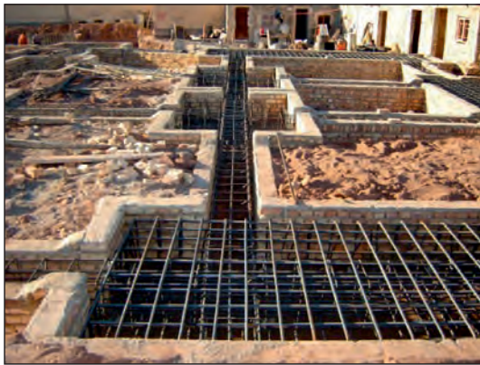
شکل ۷۰-۲ میلگردگذاری در پی کلاف بندی
