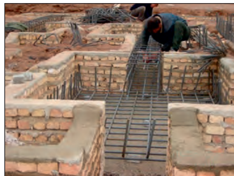
شکل ۱-۸۲ قالب‌بندی آجری در اطراف پی
