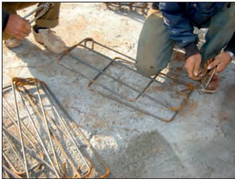
شکل ۲-۱۴۰ خم آرماتور و ساخت خاموت
