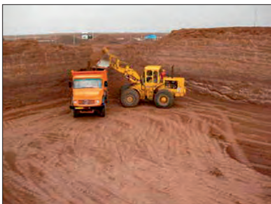
شکل ۸۵-۱ گودبرداری با لودر در زمین نامحدود
