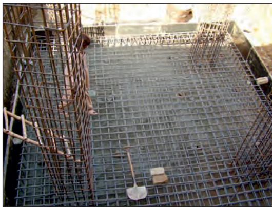
شکل ۱۵۱-۲ آرماتورگذاری پی صفحه‌ای با ستون‌های بتنی
