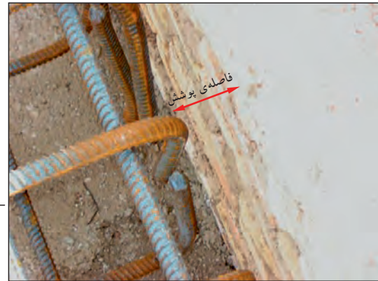
شکل ۱۲۶-۲ فاصله‌ی پوشش و قلاب سر میل‌گردها
