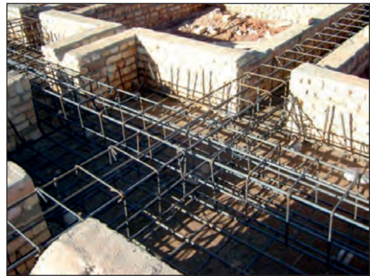
شکل ۷۱-۲ عبور میلگردهای شناژ در پی
