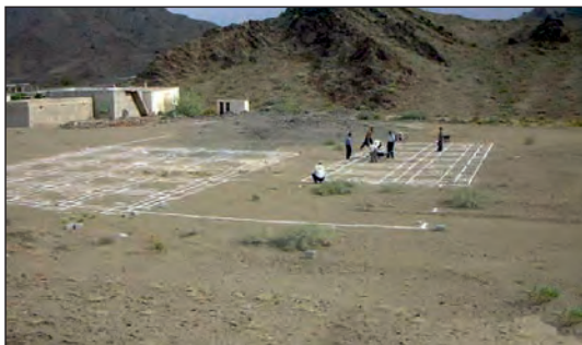
شکل ۸۳-۱ پیاده کردن نقشه روی زمین
