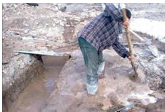
شکل ۱-۳۱ اجرای شفته آهک در فونداسیون
