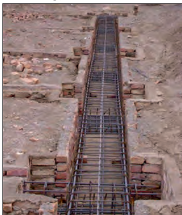
شکل ۷۲-۲ پی و شناژ قبل از بتن ریزی
