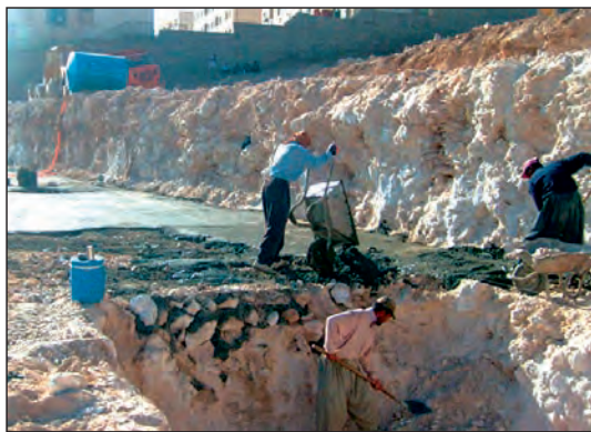
شکل ۸۷-۱ گودبرداری دستی (با بیل و کلنگ)
