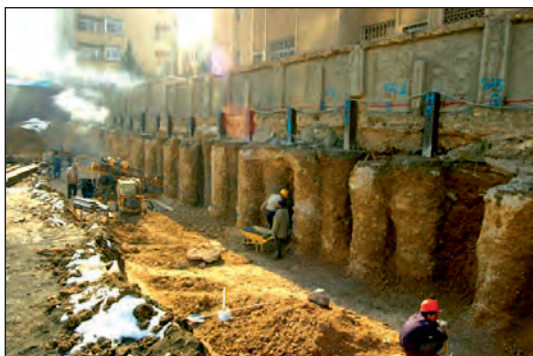
شکل ۸۸-۱ مهاربندی با پشت بند خاکی ستونی
