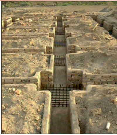
شکل ۴۸-۱ آرماتورگذاری پی تکی کلاف بندی شده
