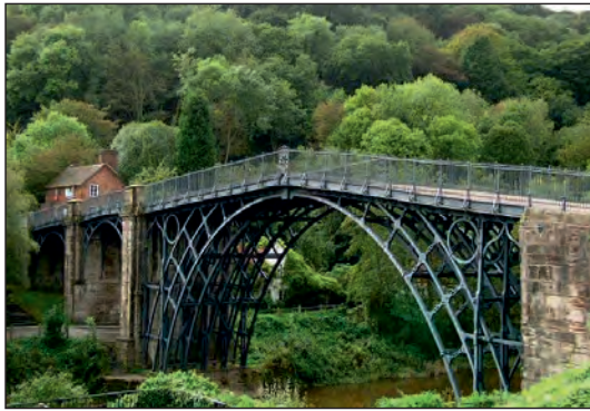
شکل ۱-۲ پل رودخانه سورن در انگلستان
