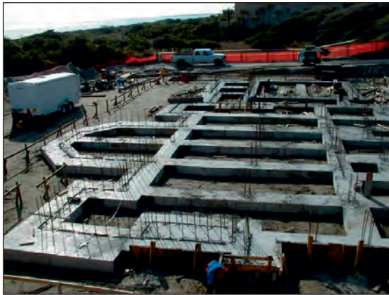
شکل ۱-۵۶ پی بتن مسلح نواری شبکه ای زیرستون
