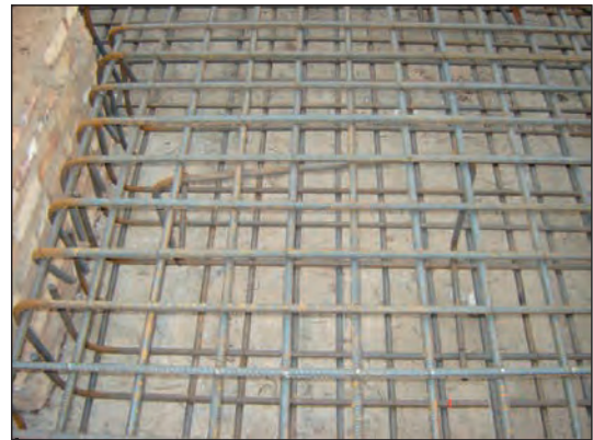
شکل ۱۴۷-۲ پی نواری و آرماتورگذاری آن
