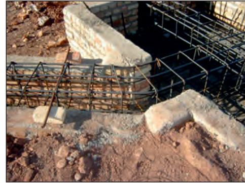
شکل ۲-۱۴۳ آرماتورهای شناژ و پی
