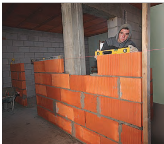
شکل ۱-۱۰۹ دیوار غیرباربر بلوک سفالی
