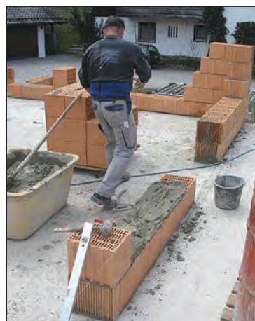
شکل ۱-۱۵۳ ساخت دیوار با بلوک سفالی
