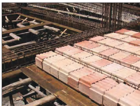
شکل ۱-۱۵۲ کاربرد بلوک سفالی در سقف
