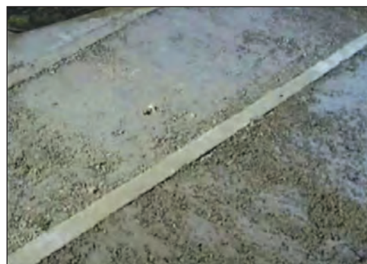
شکل ۲۱-۶ پرکردن فضای بین کرم‌ها با پوکة معدنی
