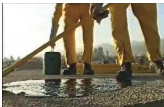
شکل ۲۲-۶ قیرگونی پس از پرکردن بین کُرم‌ها
