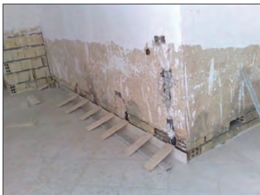
شکل ۱-۹۰ اندود گچ و خاک - گچ سفید پرداختی
