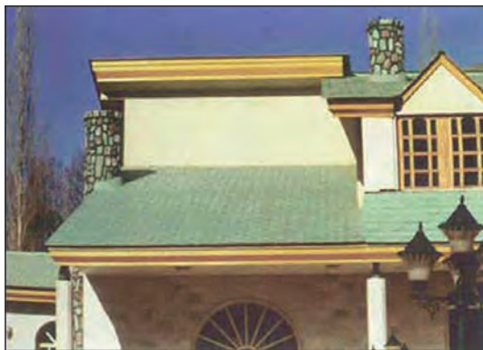
شکل ۱-۱۰۲ پوشش سقف با ورق‌های فشرده‌ی آردواز
