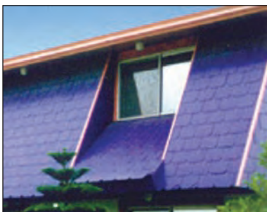
شکل ۴۷-۱ پوشش نهایی سقف شیب‌دار با آردواز
