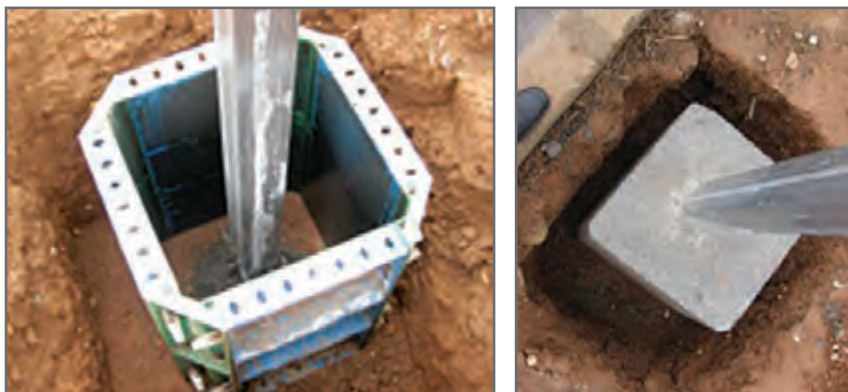
شکل ۸- فونداسیون سازه گلخانه
