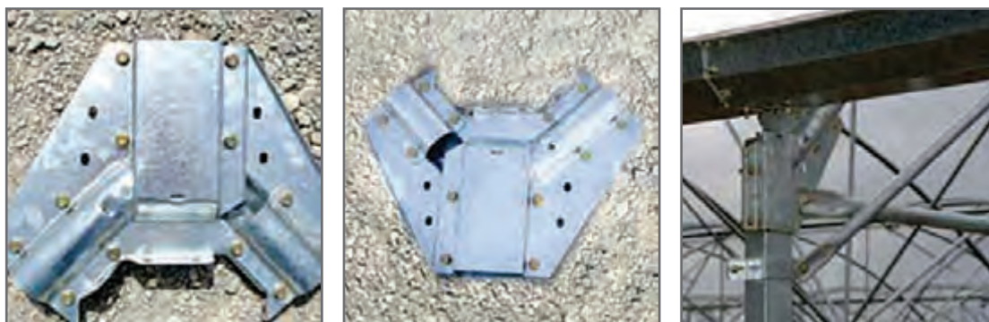
شکل ۷- اجزای اتصالات گلخانه
