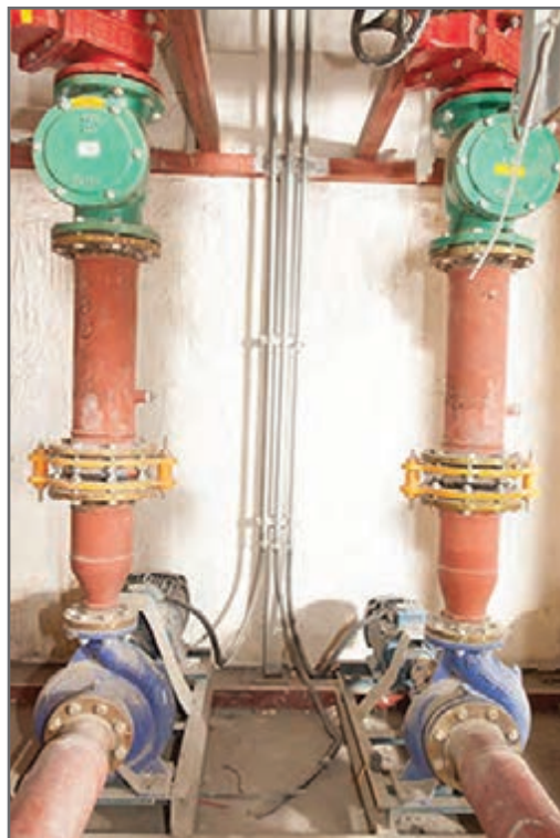
شکل ۳۲ - خط رانش پمپ زمینی
