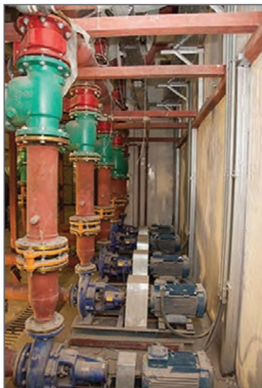
شکل ۳۲ - خط رانش پمپ زمینی
