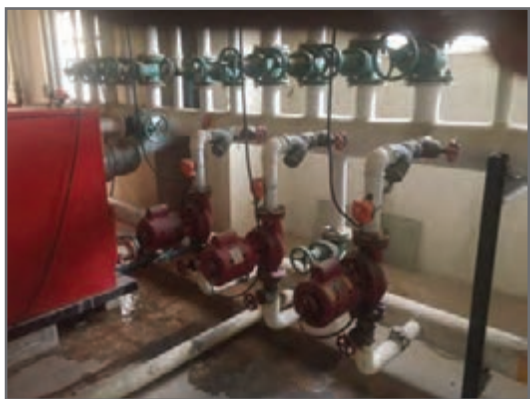
شکل ۱ - پمپ سیرکولاتور سیستم گرمایی
