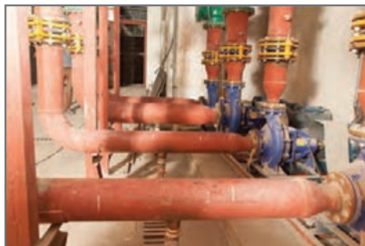
شکل ۳۳- خط مکش پمپ زمینی
