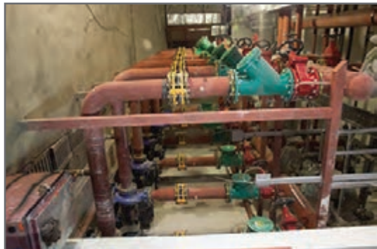
شکل ۳۳- خط مکش پمپ زمینی
