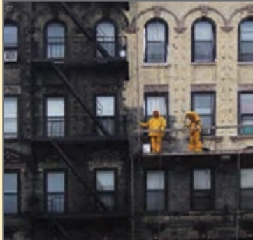
دوده زدایی بر روی نمای ساختمان
