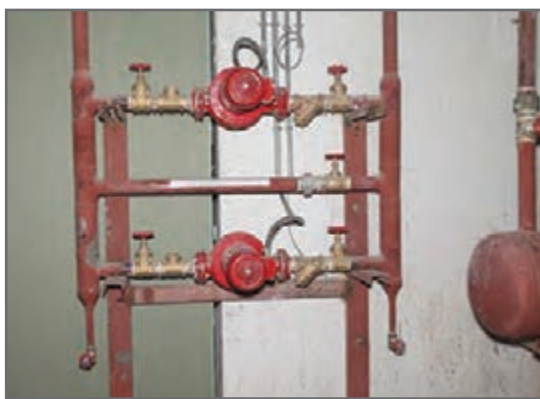
شکل ۱ - پمپ سیرکولاتور سیستم گرمایی
