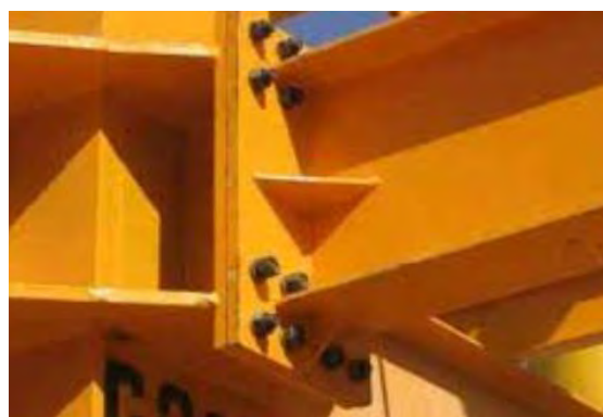
شکل ۳-۱۸ (ب) سازه فلزی اتصال پیچ و مهره
