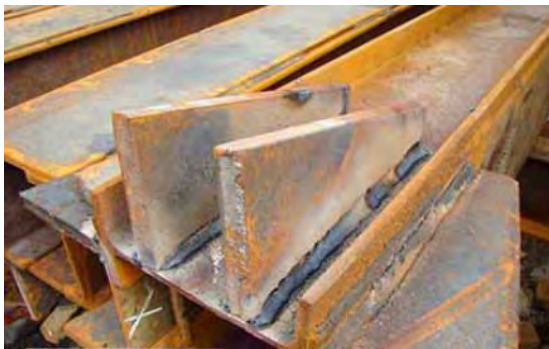
ب) شکل ۳-۱۹ اتصال سازه فلزی جوش کاری
