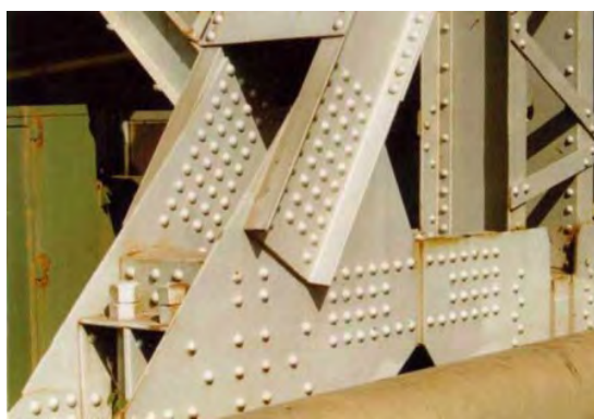
شکل ۳-۱۸ (الف) سازه فلزی اتصال پرچی
