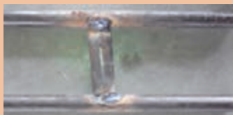
شکل ۱۷- ثابت کردن لوله فلزی
