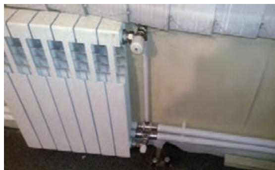
شکل ۶۱- اتصال سر لوله رادیاتور روکار
