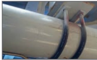
شکل ۱۷- تکیه‌گاه لوله افقی
