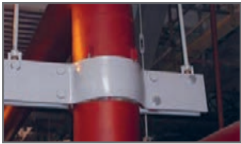
شکل ۱۸- تکیه‌گاه لوله قائم
