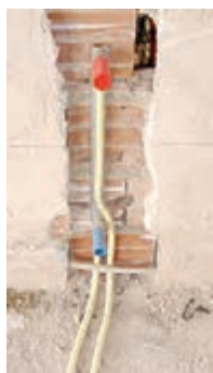
شکل ۶۲- اتصال سر لوله رادیاتور با شابلون زیرکار
