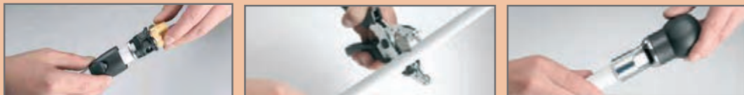
شکل ۵۱ - مراحل اجرای اتصال قفل شونده
