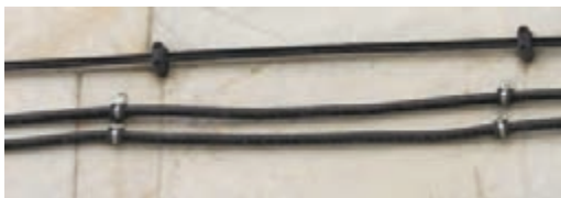
شکل ۲۷ - فاصله بین بست‌ها
