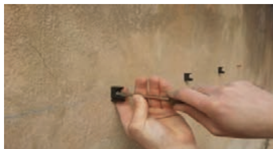
شکل ۳۶- نصب اولیه بست
