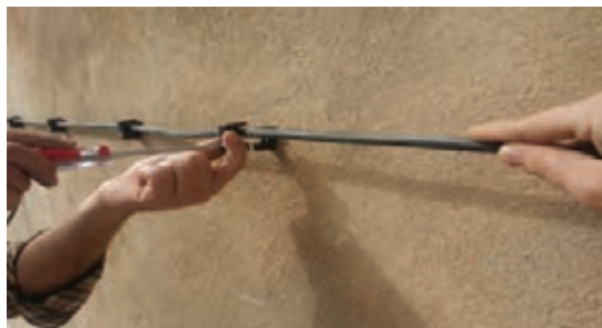
شکل ۳۷- کابل نصب شده روی دیوار
