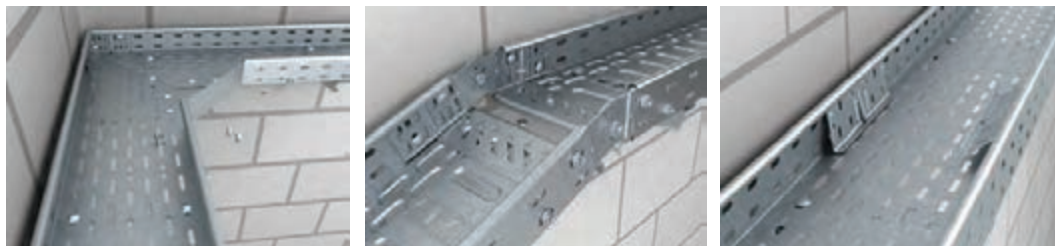
شکل ۴۴- اتصالات سینی کابل
