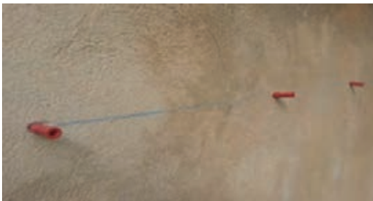
شکل ۳۵- نصب رول پلاک‌ها
