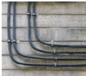
شکل ۲۱- خمش کابل
