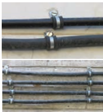
شکل ۲۵- کابل‌کشی روی دیوار
