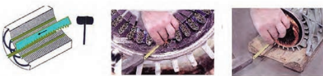
شکل ۲۳- خارج کردن پرسپان از شیار
