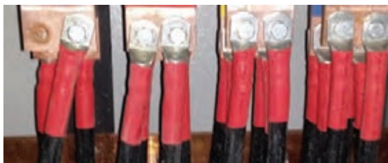
شکل ۱۷- عایق حرارتی کابلشو
