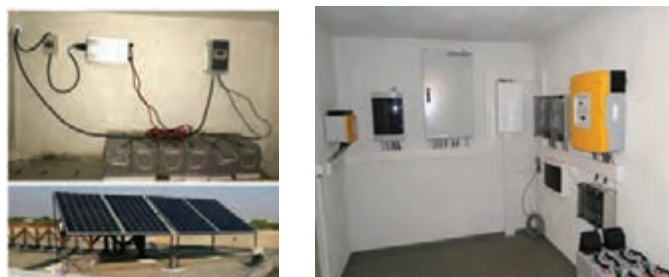
شکل ۴۶- اجرای دو نمونه سیم‌کشی سیستم فتوولتاییک
