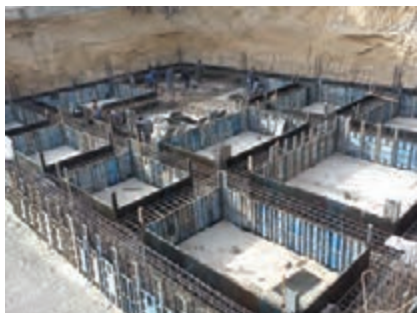
شکل ۵ – قبل از بتن‌ریزی (شالوده)
