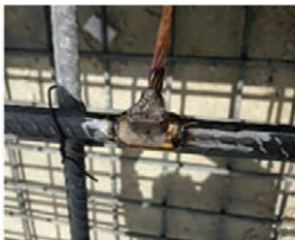
شکل ۱۱- اتصال هادی همبندی مسی به میلگردهای موجود در سازه با استفاده از جوش احتراقی
