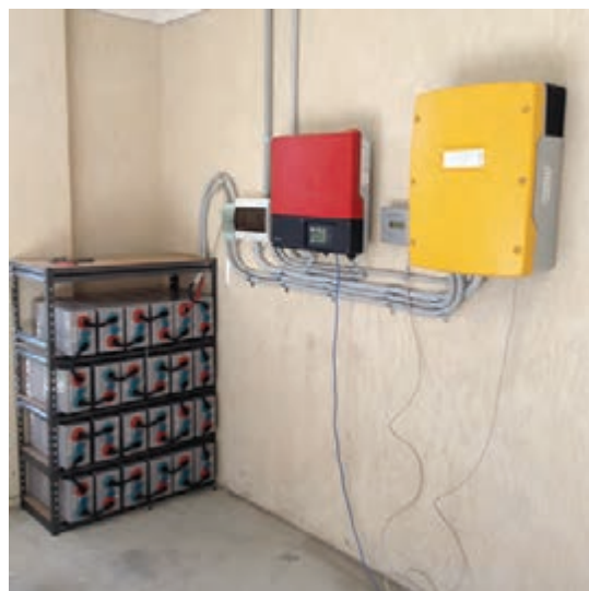
شکل ۶۱- اتصالات سیستم فتوولتائیک
