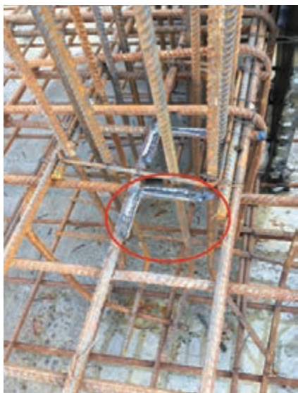
شکل ۱۹- جوشکاری میلگردها در یک تقاطع چهارراه
