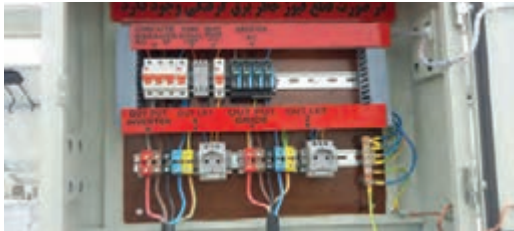
شکل ۶۴- نصب سرچ ارستر
