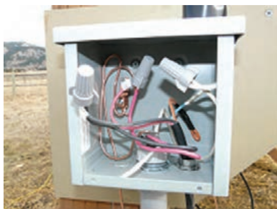
شکل ۳۵- اتصال میله مسی به بدنه تابلو اتصالات
