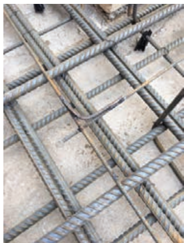
شکل ۲۱- جوش کاری میلگردها در تقاطع سه راهه
