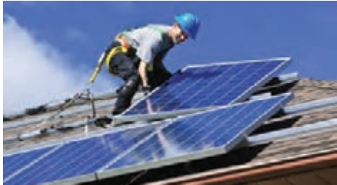
شکل ۵۷- استفاده از بست مناسب
