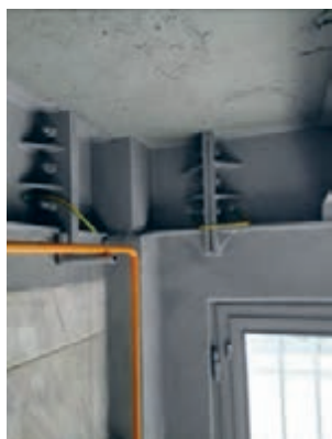
شکل ۲۴- اتصال اسکلت فلزی بیچی
