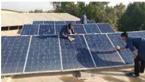
شکل ۴- تمیز کردن مدول‌های خورشیدی
