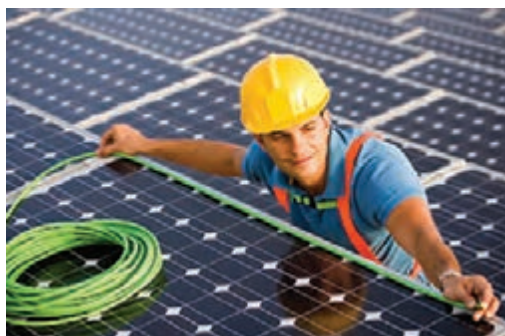
شکل ۳۰- همبندی بدنه فلزی آرایه‌ها و اینورتر
