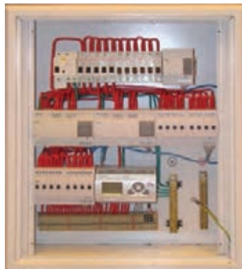
شکل ۵۳- دو نمونه تابلوی توزیع برق (DP)
