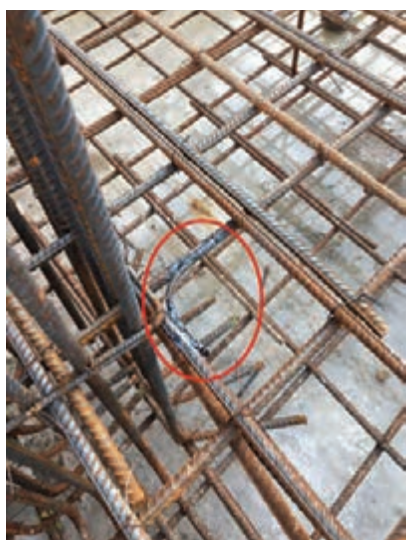
شکل ۲۰- جوشکاری میلگردها در گوشه
