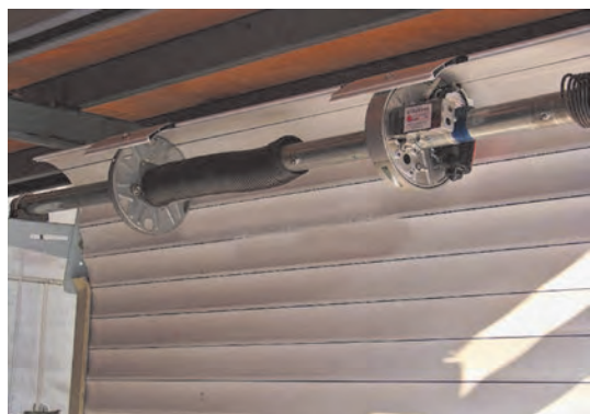
شکل ۱۱- محل نصب موتور کرکره‌ای
