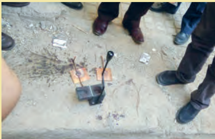
شکل ۹۸- رعایت فاصله از بوتۀ مخصوص جوش اگزوترمیک
