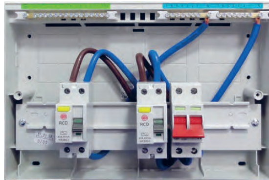
شکل ۴۷- سیم‌کشی قطعات تابلو
