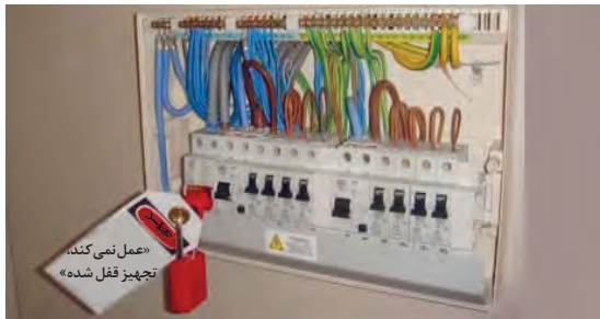
شکل ۵۳- نصب برچسب و قفل
