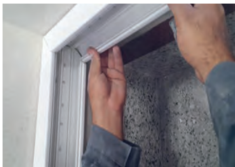
شکل ۵۰- برش و فارسی بر کردن ترانکینگ
