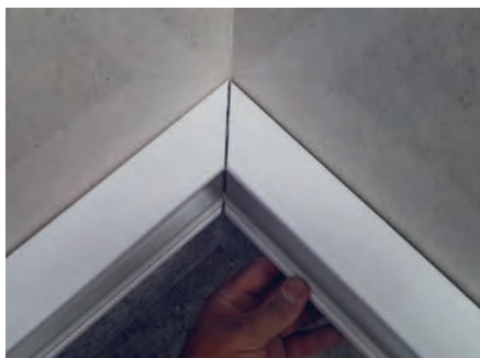
شکل ۵۰- برش و فارسی بر کردن ترانکینگ
