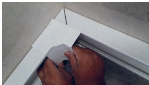
شکل ۵۱- نصب زانوی داخلی
