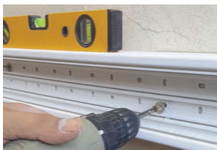
شکل ۴۹- نصب ترانکینگ
