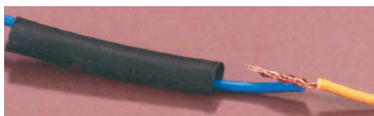
شکل ۲۲- عایق‌کاری اتصال
