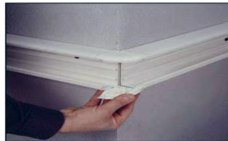
شکل ۴۴- نصب درپوش ترانکینگ زاویه دار
