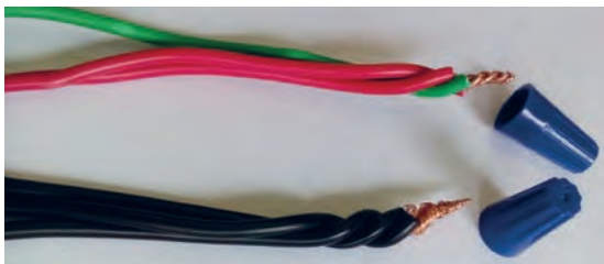
شکل ۴۴- آماده کردن سیم
