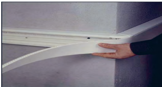
شکل ۴۴- نصب درپوش ترانکینگ زاویه دار
