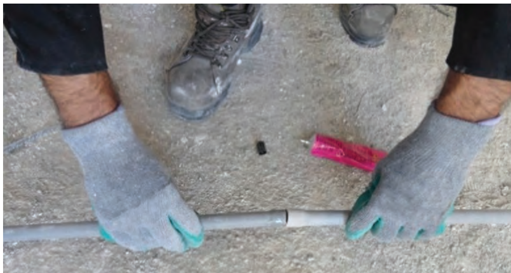
شکل ۴۵- اتصال لوله PVC
