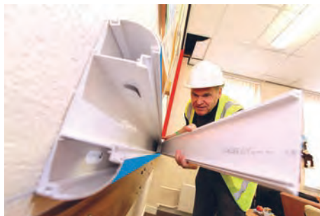
شکل ۴۳- نصب درپوش ترانکینگ
