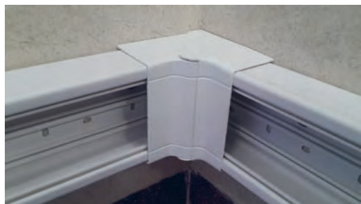
شکل ۵۱- نصب زانوی داخلی
