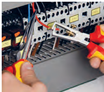
شکل ۹- روکش برداری با سیم لخت کن دستی
