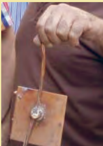
شکل ۹۷- جوش اگزوترمیک
