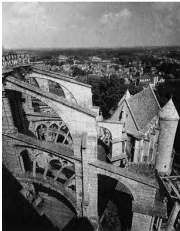
تصویر ۳۴- خایل‌های توخالی دیوارها در معماری گوتیک
