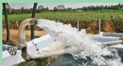
شکل ۱۶- لوله برگشت آب
