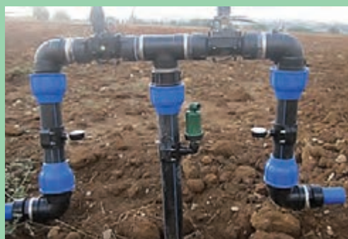
شکل ۱۸- شیر و فشارسنج روی بال ها
