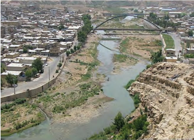
شکل ۷-۵ - خرم‌رود در فصل کم آبی
