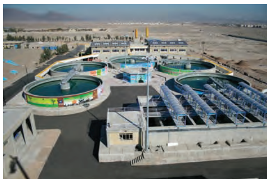
شکل ۱۳-۴- تصفیه خانه آب زاهدان
