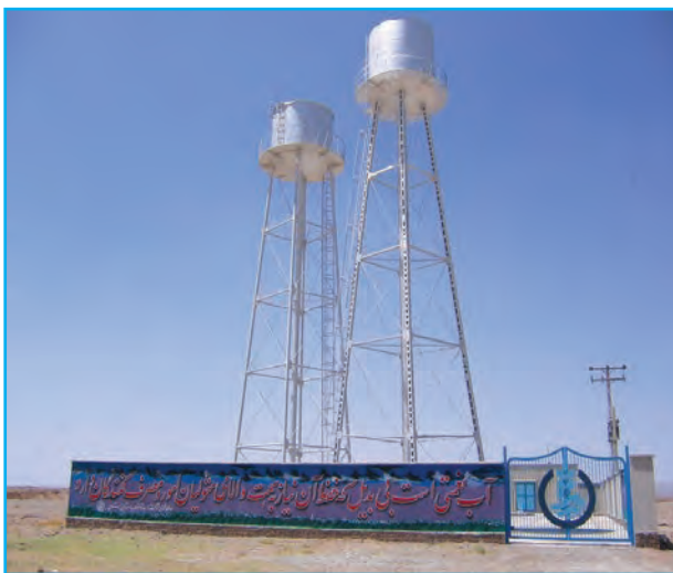
شکل ۱۰-۱۴- اجرای طرح آبرسانی بهداشتی روستایی
