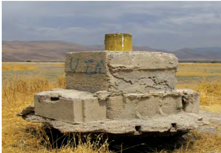
تصویر ۸-۴- پدیده فرونشست زمین (منطقه خانمیرزا)
