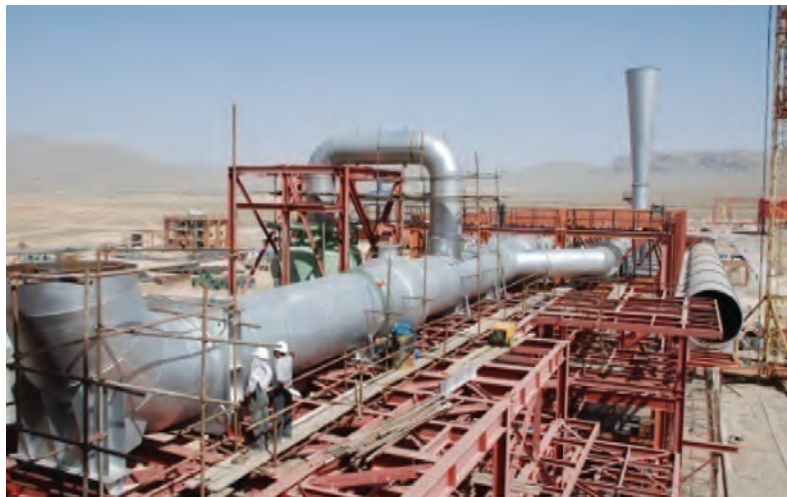
تصویر ۱-۱۵- کارخانه درحال احداث فولاد چهارمحال
