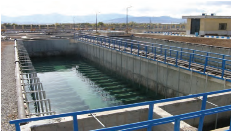
تصویر ۱-۵- تصفیه خانه شهرک صنعتی شهرکرد
