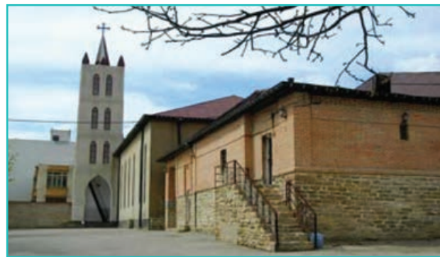
شکل ۳۹- کلیسای ننه مریم - ارومیه
